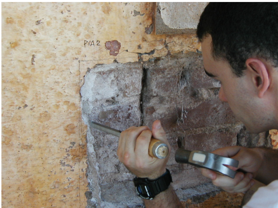
Escavações arqueológicas, sítio arqueológico histórico Estação Ferroviária de Piraju, Município de Piraju - SP. Na imagem superior, escavação de uma trincheira exploratória; na inferior, sondagens na parede da edificação principal para a compreensão das técnicas construtivas [fonte: Projeto Paranapanema]
