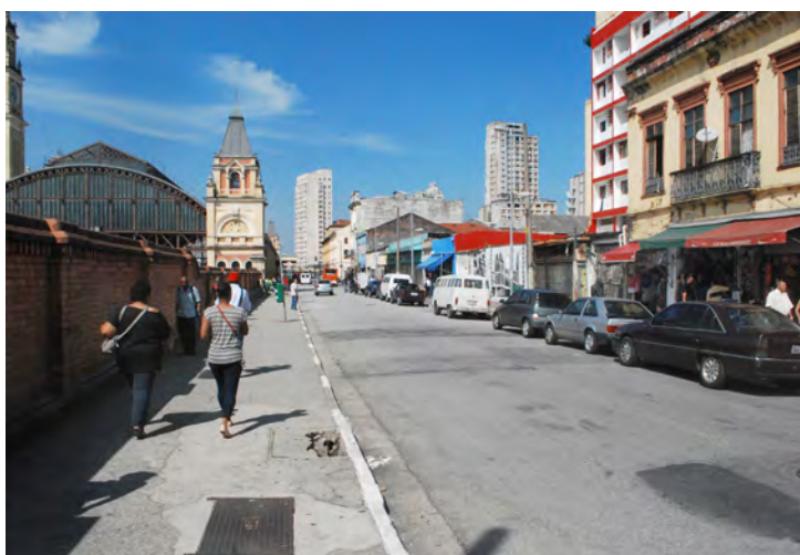
FIGURA 123. A parte traseira da Estação dá a ver a paisagem de uma São Paulo degradada. São muitos os cortiços e prédios invadidos. Vê-se ainda buracos na calçada. Fonte: autora.
