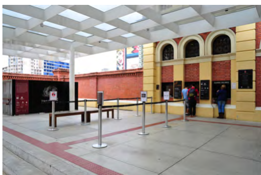
FIGURA 142. A extremidade onde se localiza a entrada do museu recebeu uma cobertura de metal e vidro no momento do restauro. Ela, ao mesmo tempo que permite a passagem da luz através do vidro, encobre uma parcela do espaço aberto, inclusive os guichês da bilheteria e chapelaria. Fonte: autora.
