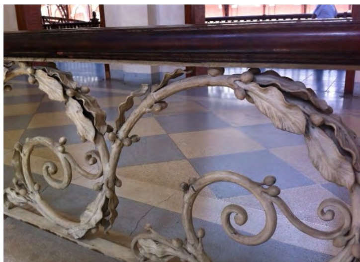
FIGURA 120. Detalhe das grades de ferro do saguão da Estação da Luz, em cujos anteparos nas escadas ramos com grãos de café estão fundidos. Fonte: autora.
