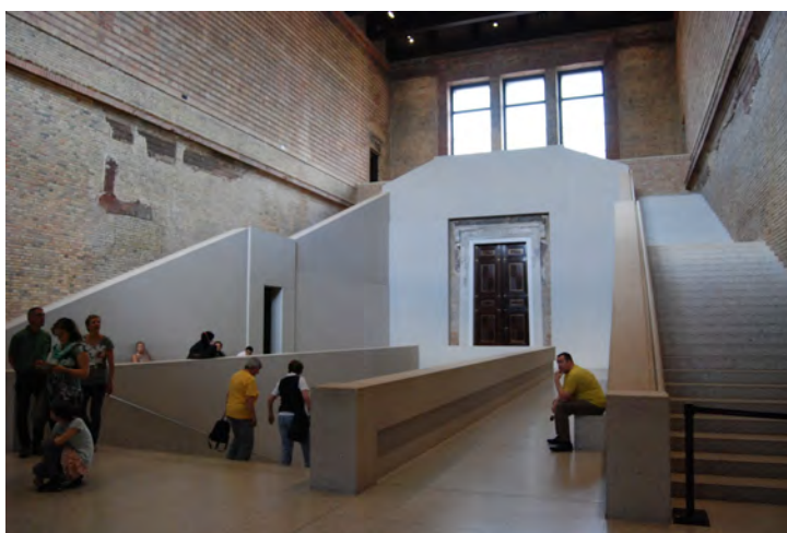
FIGURA 52. A construção no interior do Neues Museum data de diferentes épocas, e apesar das formas e materiais mais modernos serem visivelmente sentidos, há um equilíbrio arquitetônico. Vide, por exemplo, a parede de tijolos restaurados e a escada implantada. Fonte: autora.
