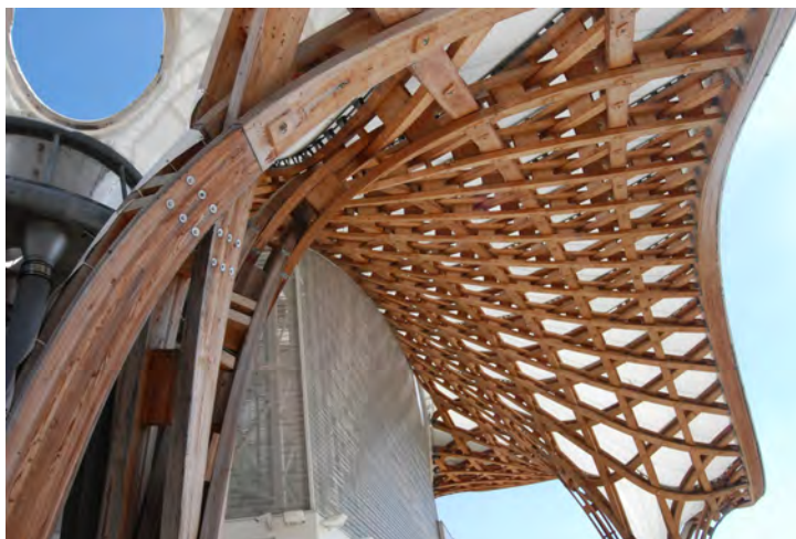
FIGURA 29. Detalhe do trabalho da madeira entrelaçada na cobertura do museu, que figurativiza um chapéu de palha, posto na centralidade da “cabeça” do prédio. Fonte: autora.
