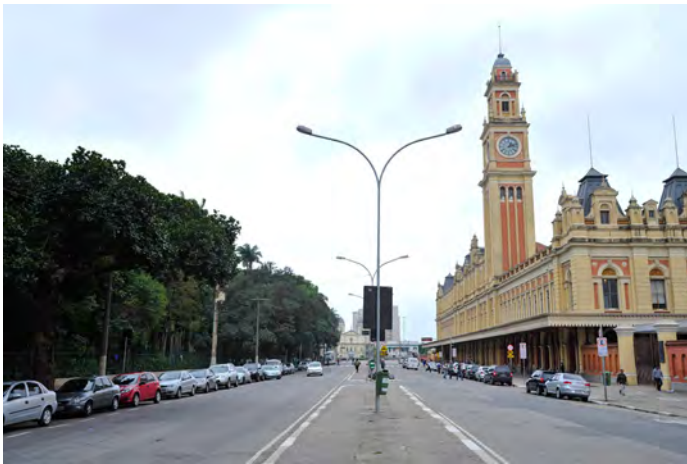
FIGURA 103. O canteiro central da rua, entre o Parque e a Estação, divide a mão de circulação dos carros, conforme vê-se no estacionar. Diferentemente do dia da feira de automóveis antigos, em dias de semana rotineiros, não se observa um intenso fluxo de automóveis, mesmo nos horários de pico, como acontece na cidade como um todo. Nessa área, a verticalidade se dá pela torre do relógio e pelas altas árvores do Parque, mas, mesmo assim, predomina a paisagem aberta (horizontal) se comparado a cidade ao redor. Fonte: autora.
