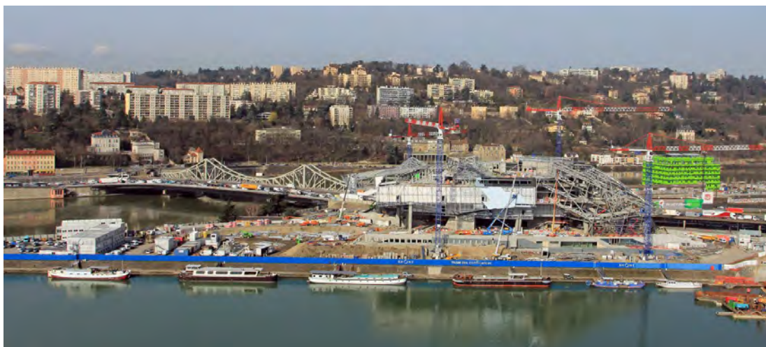
FIGURA 32. Vista aérea do canteiro de obras do museu que nasce em Lyon, no bairro de Perrache, bem na extremidade onde os rios se encontram e por isso o nome Confluence. Fonte: < http://www.coop-himmelblau.at >. Acesso em: 28 jul. 2014.
