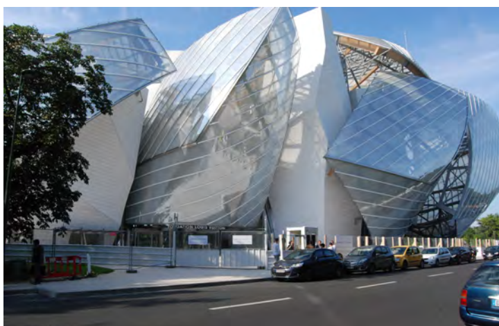
FIGURA 18. Fotografia do canteiro de obras da Fondation Louis Vuitton inaugurada em outubro de 2014. O prédio, de arquitetura orgânica, é construído em vidro e ferro, e algumas vigas de madeira são visíveis, dialogando com o bosque em que o mesmo encontra-se inserido. Fonte: autora.
