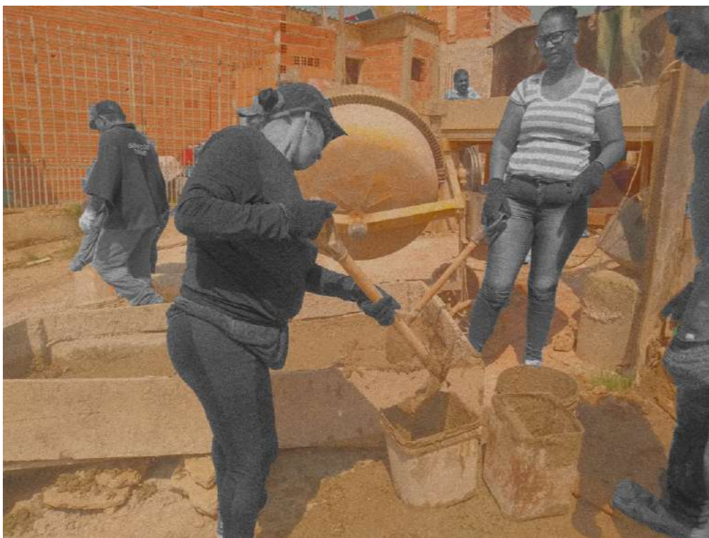
Foto 36: Mutirão de construção das casas embrião
