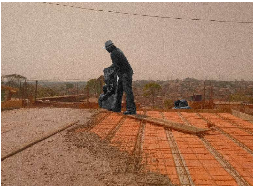
Foto 37: Mutirão de construção das casas embrião
