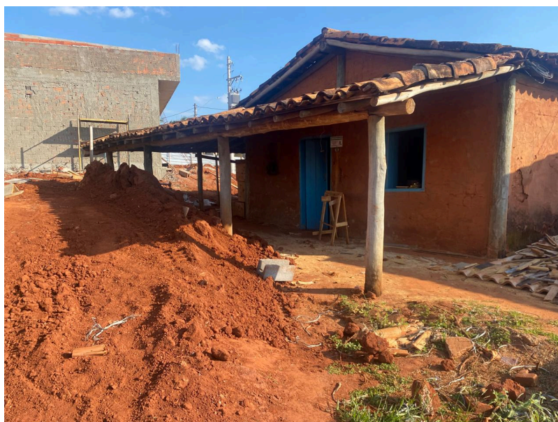
Figura 11 - Foto da “Casa do Caboclo”, em reforma.
