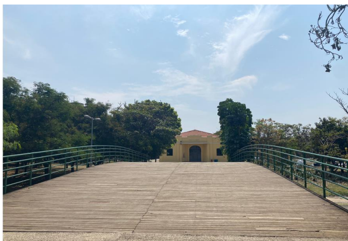
Fotografia 19 – Rampa de acesso ao Café Concerto (Teatro)
