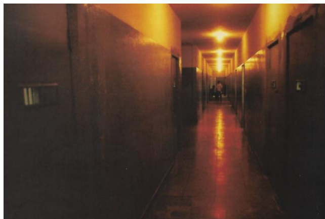
Fotografia 30 – Corredor sem iluminação
