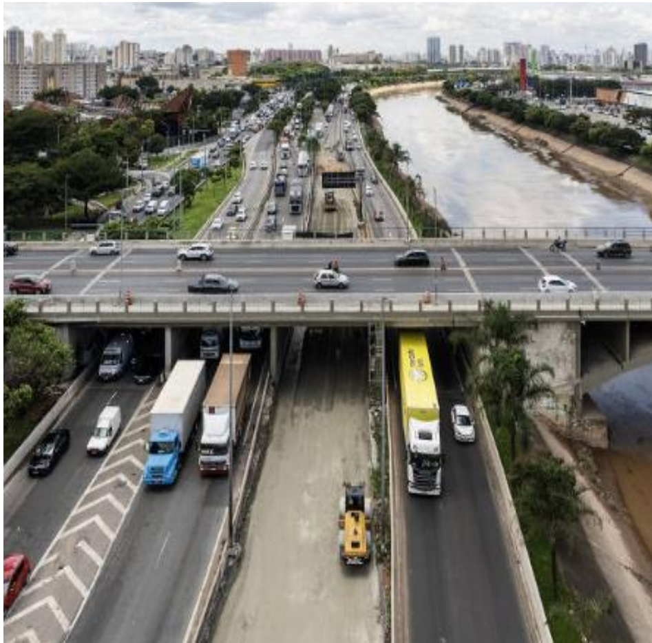
Figura 4 - Imagem frontal da ponte do Jaguaré
