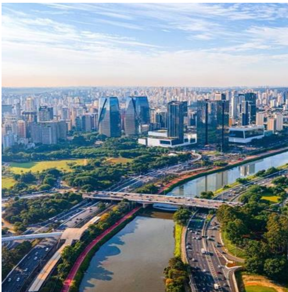
Figura 5 - Imagem aérea da ponte do Jaguaré
