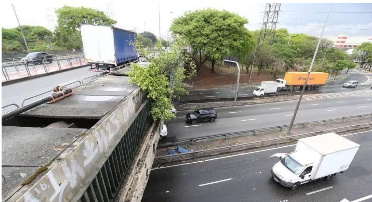
Figura 9 - Vista frontal da Ponte Presidente Jânio Quadros
