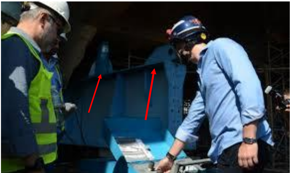
Figura 7 - Utilização de macacos hidráulicos para estabilizar a ponte do Jaguaré
