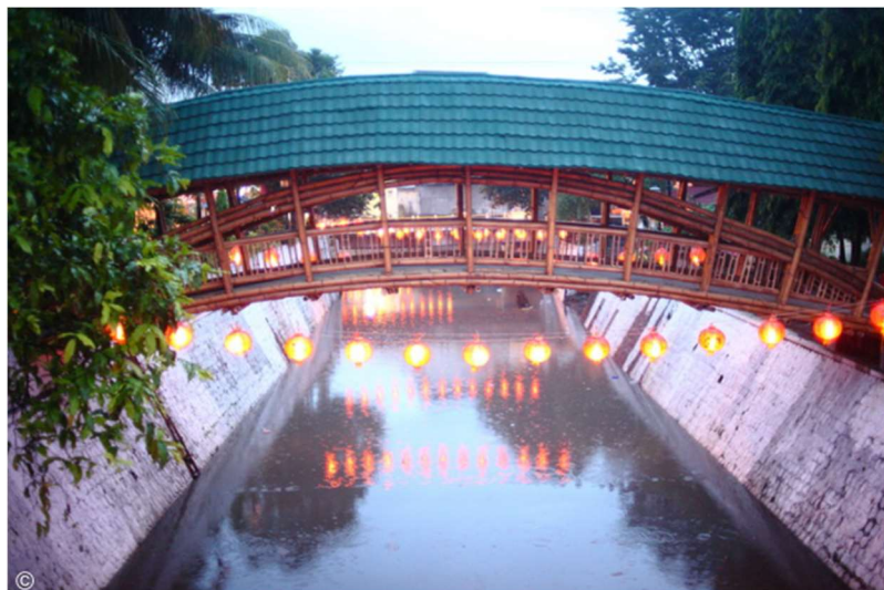
Figura 16 - Ponte na Indonésia (vista 1).
