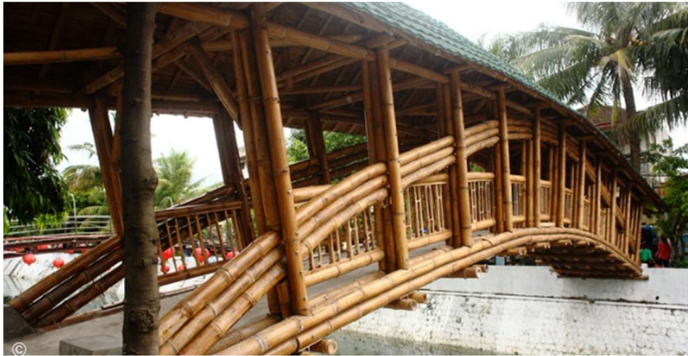
Figura 17 - Ponte na Indonésia (vista 2).
