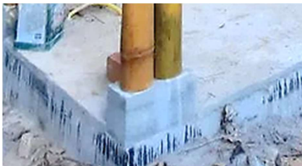
Figura 59 - Execução de ancoragem de pilar regular.
