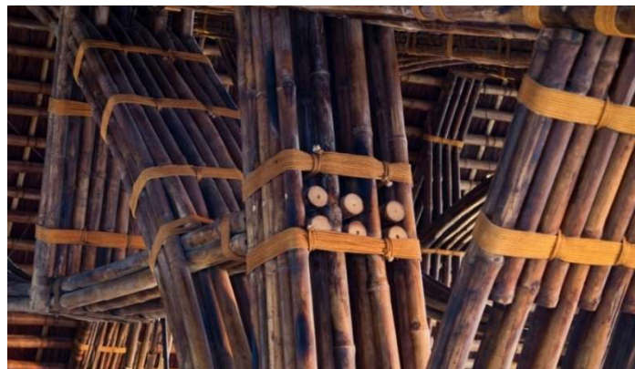
Figura 35 - Naman Retreat Beach Bar projetado por Vo Trong Nghia Architects. Detalhe das amarras e junções.
