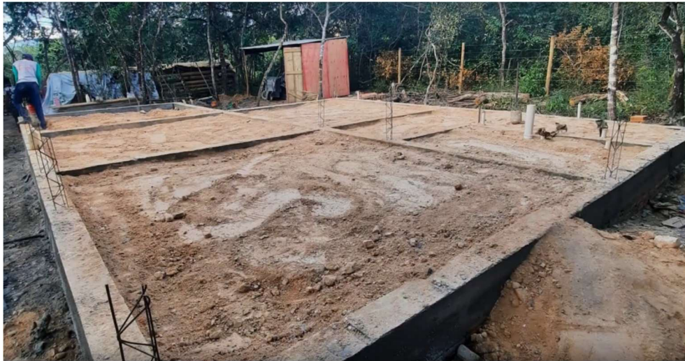
Figura 57 - Fundação e esperas de treliça da Cabana Belchior.
