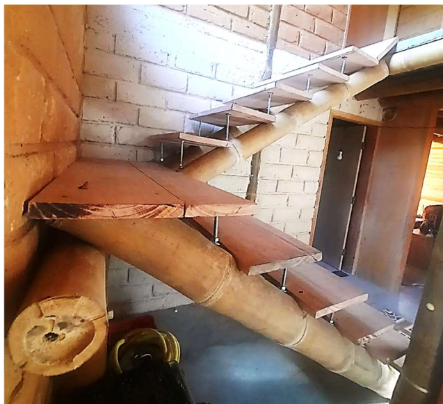
Figura 74 - Cabana Belchior (vista lateral da escada).
