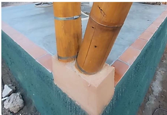
Figura 61 - Execução de ancoragem de pilar inclinado.
