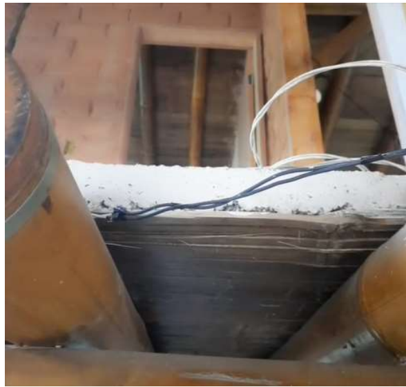
Figura 64 - Detalhe da laje.
