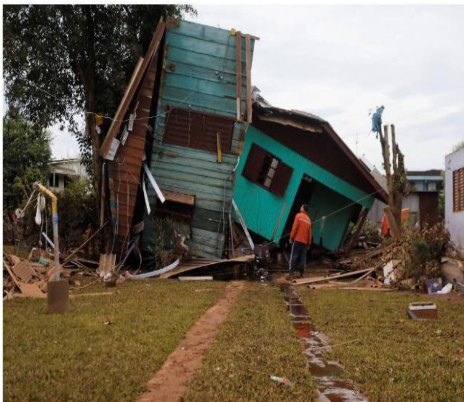
Figura 17 - Homem olha para edificação destruída, em Roca Sales-RS, após chuvas intensas em setembro de 2023
