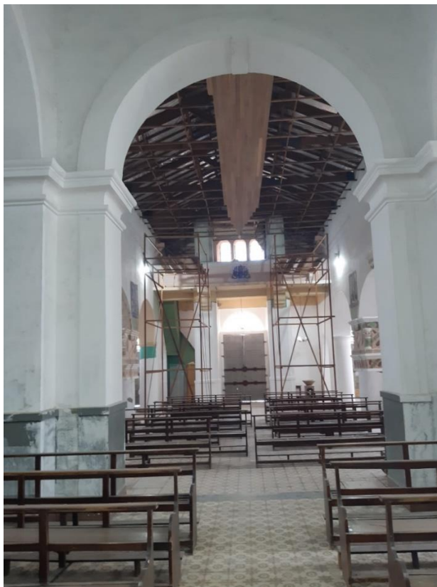
Figura 2 - Restauração da cobertura da igreja
