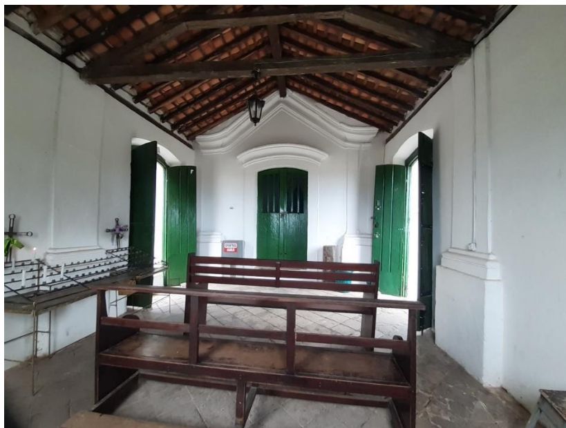
Figura 31 - Parte interna da Capela de Nossa Senhora das Dores
