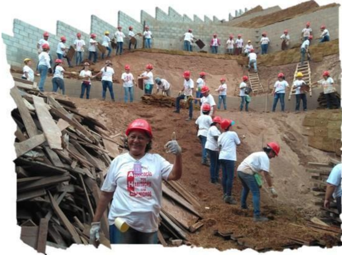
Figura 1 – Mutirantes no canteiro de obras da AHD (2019)
