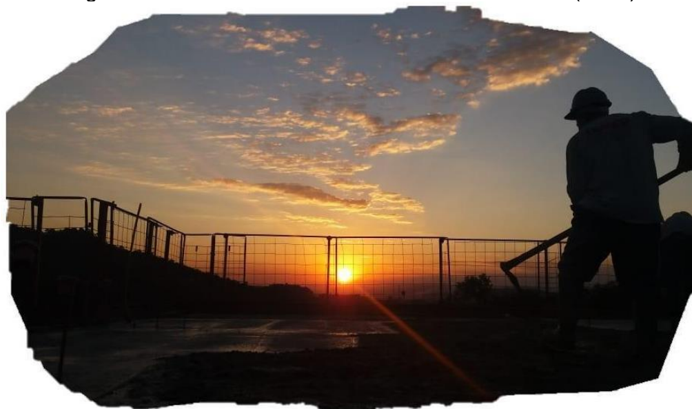
Figura 24 – Mutirante no canteiro de obras da AHD (2020)
