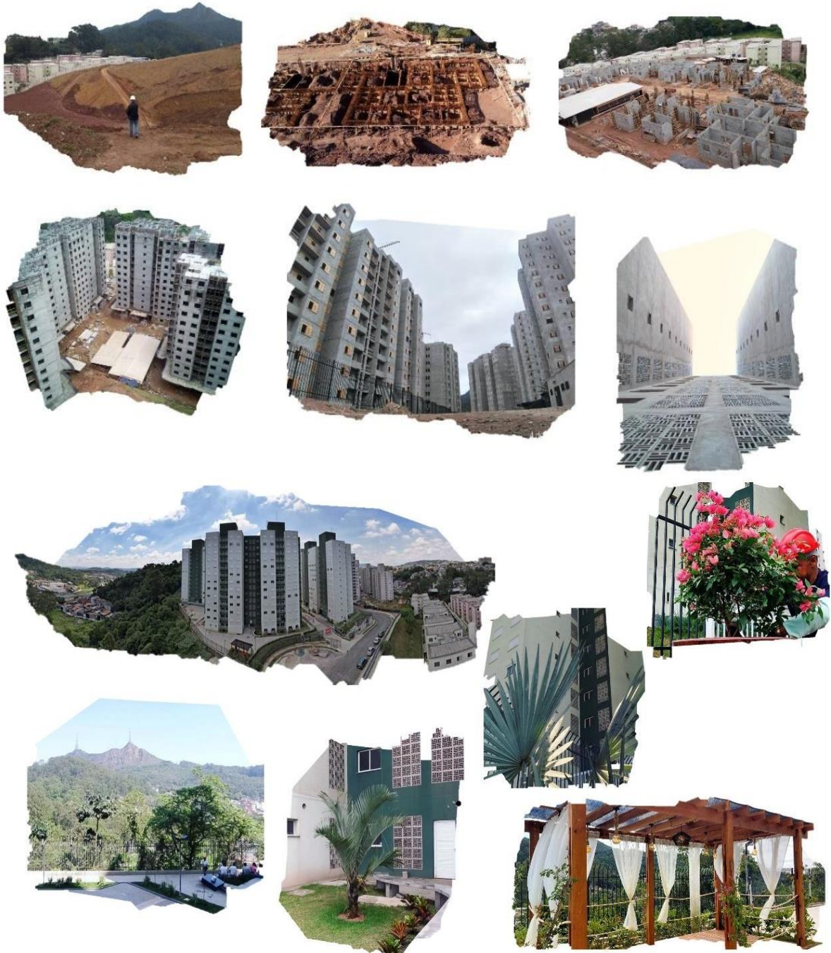
Figura 6 – Processo de construção do Condomínio Alvorada Jaraguá (2017-atualmente)
