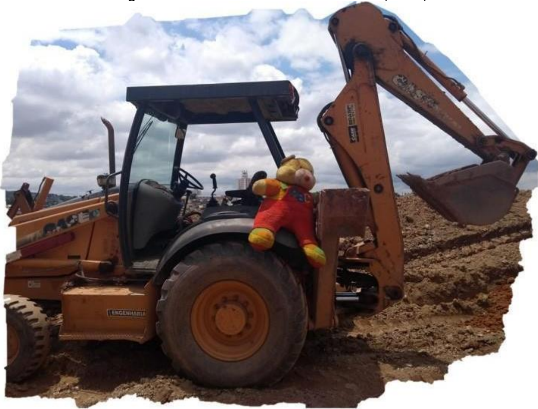
Figura 2 – Canteiro de obras da AHD (2019)
