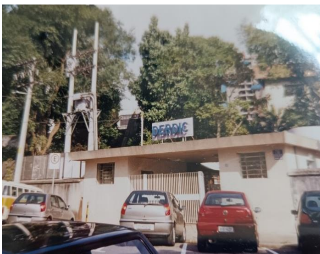
Figura 11. Fachada atual do prédio DERDIC/ IESP
