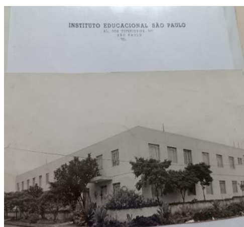
Figura 8. Terceira instalação do IESP
