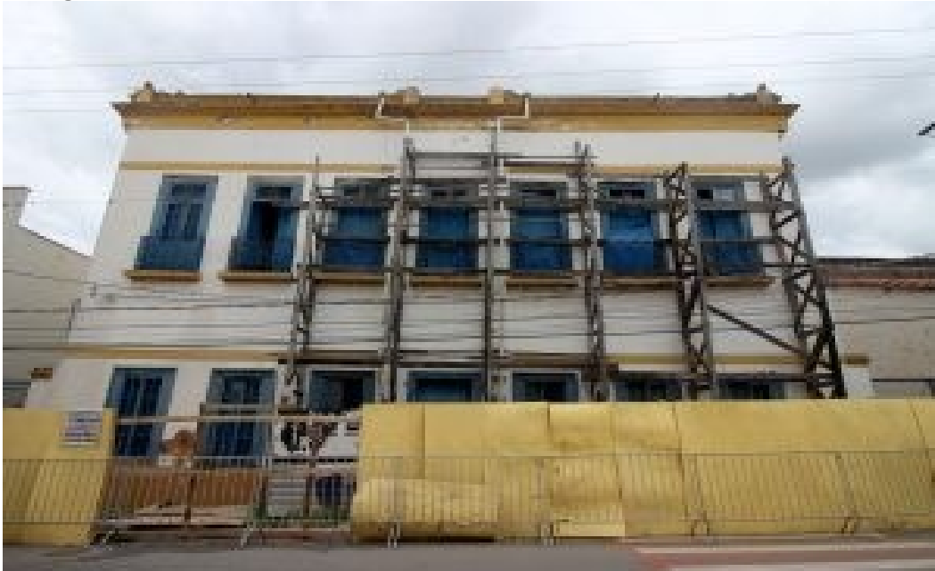
Fotografia 1 - Museu das Monções – em restauração
