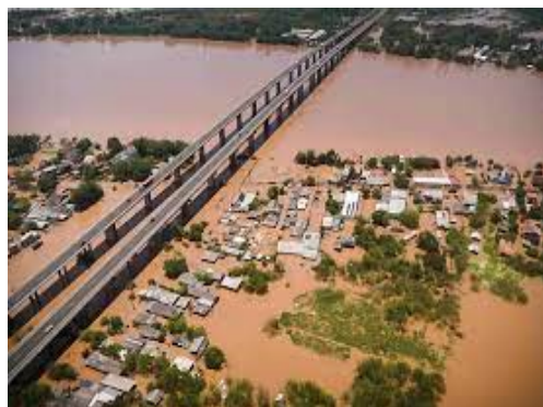
Figura 5 – Regiões alagadas no Sul
