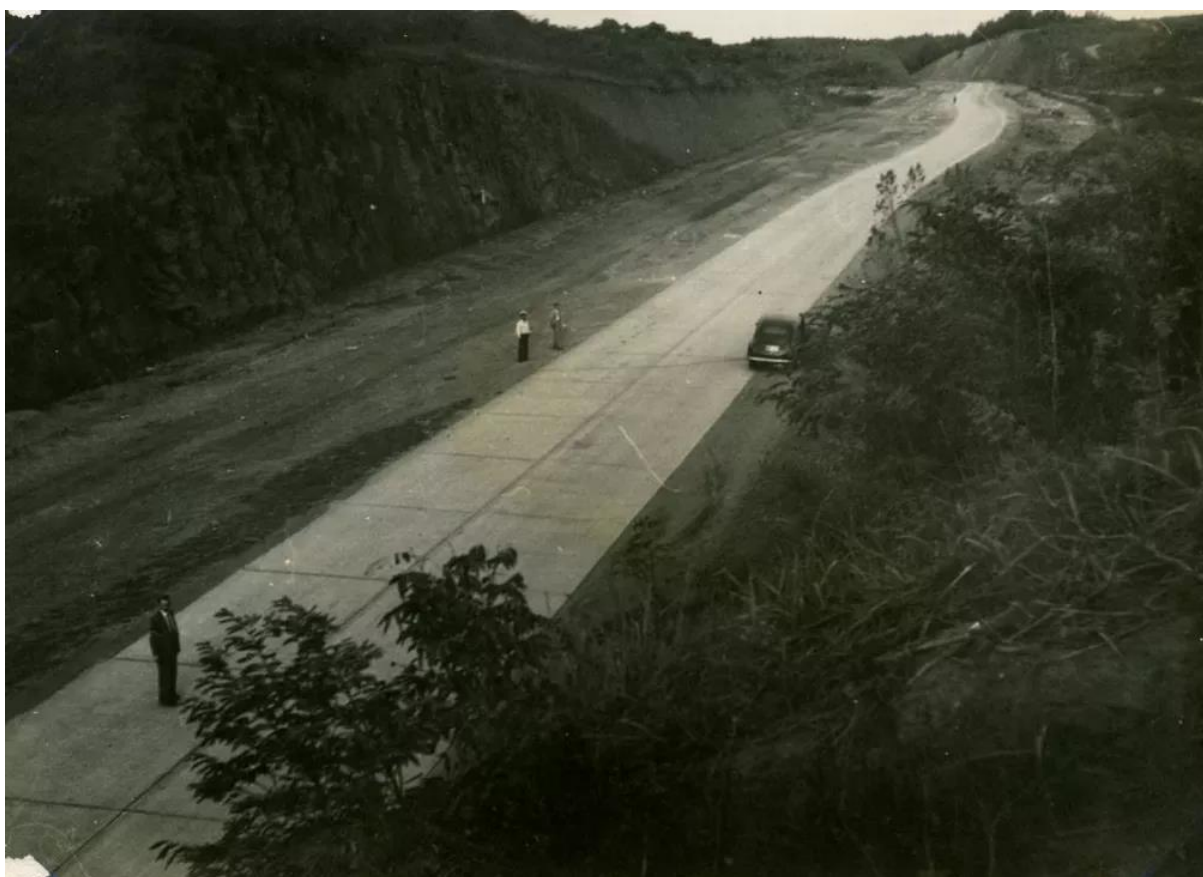
Figura 2 – Rodovia Anhanguera em construção
