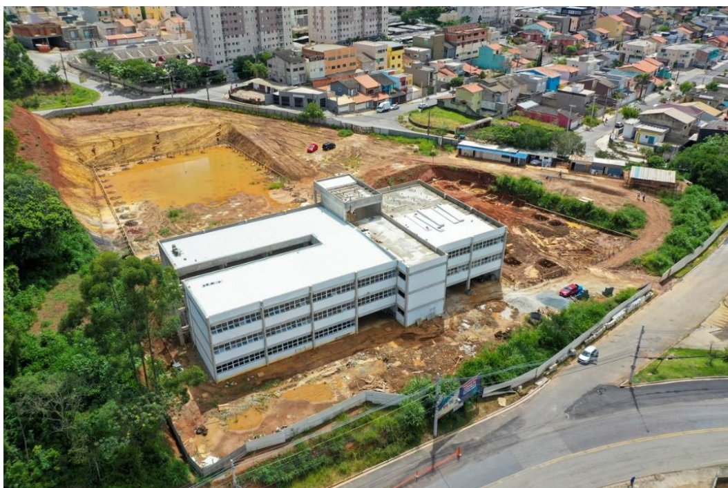
Figura 26 – Universidade municipal de logística de Cajamar
