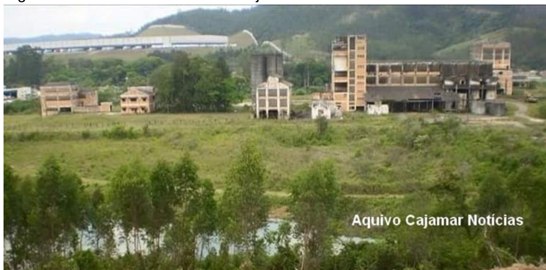
Figura 22 – Fábrica de Cimento Cajamar
