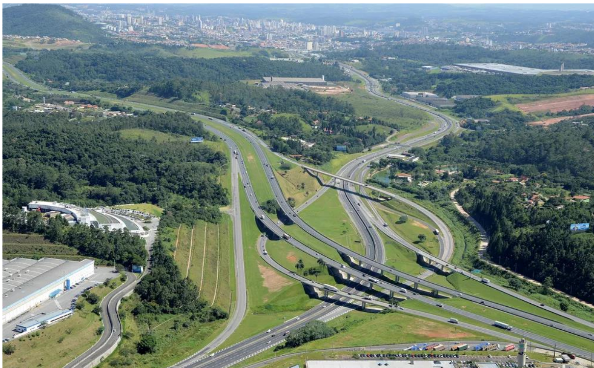
Figura 3 – De outro ângulo, o entroncamento entre as rodovias Anhanguera e Bandeirantes
