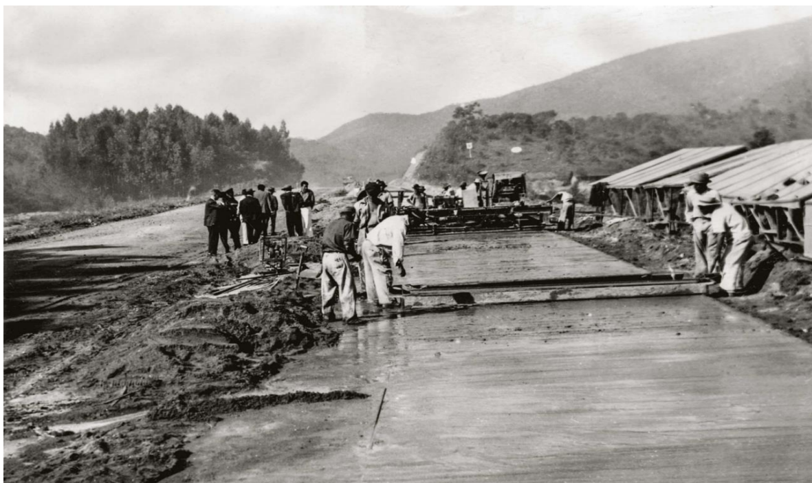
Figura 1 – Trabalhadores na construção da Rodovia Anhanguera. Estrada foi inaugurada em 22 de abril de 1948
