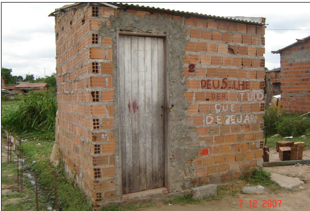
Figura 68. Invasão Juca Campelo – condições precárias de moradia.
