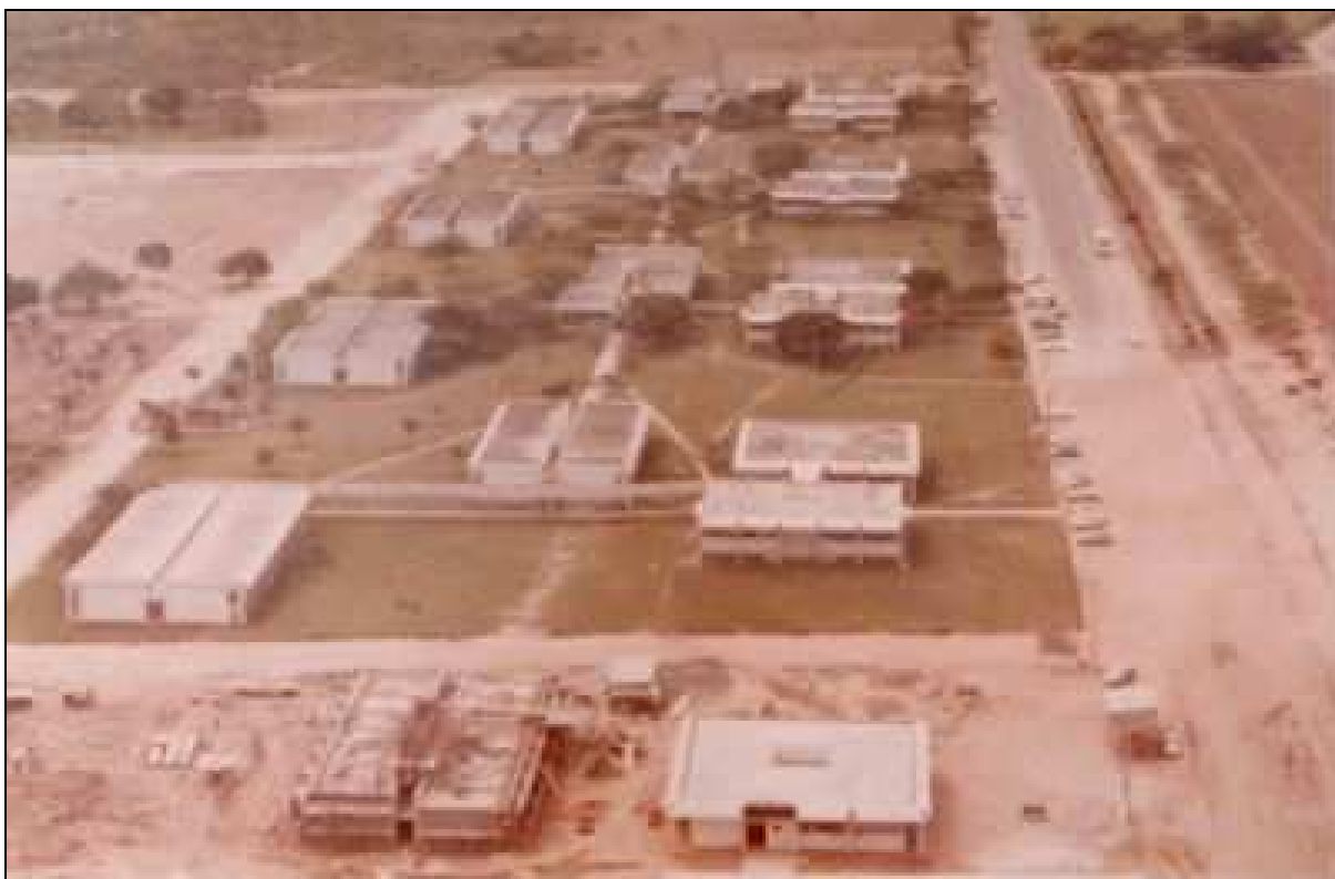
Figura 44. Campus da Universidade Estadual de Feira de Santana, com dois módulos em construção - 2000.
