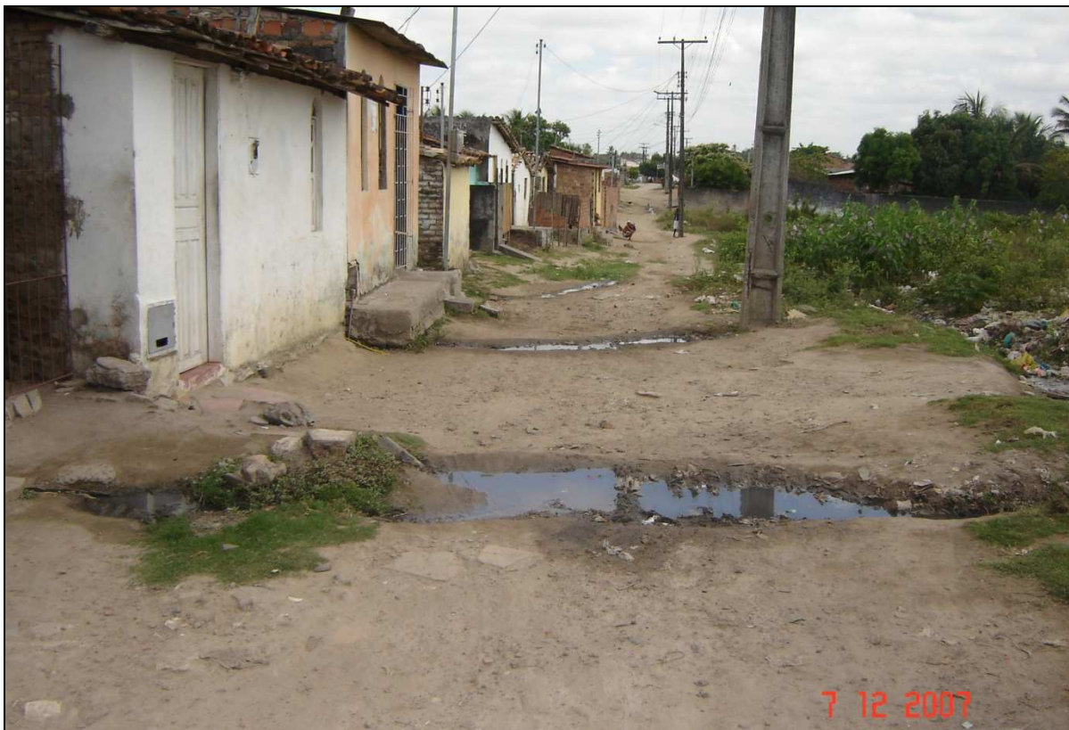
Figura 68. Invasão Juca Campelo – esgoto lançado a céu aberto
