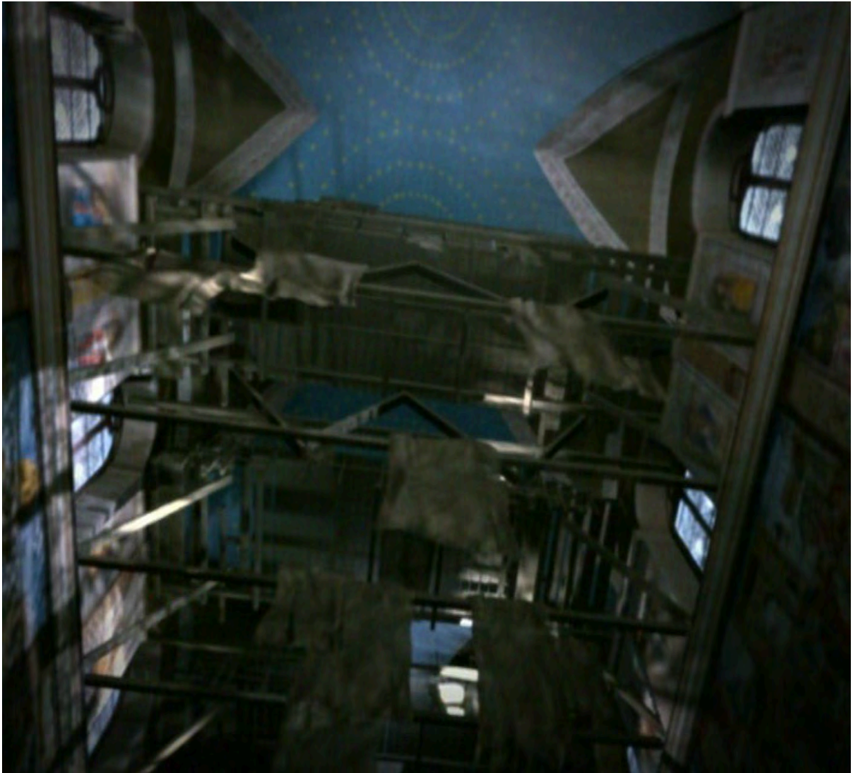
Figura 19 - Vista debaixo dos andaimes
