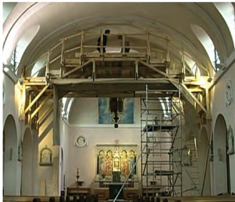
Figura 18 - Réplica do sistema de andaimes
