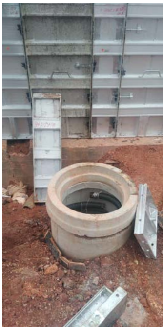
Figura 6 - Formas metálicas para concreto
