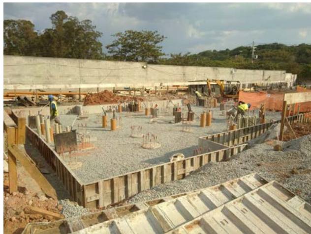
Figura 8 - Lajão sendo preparado com forma metálica;
