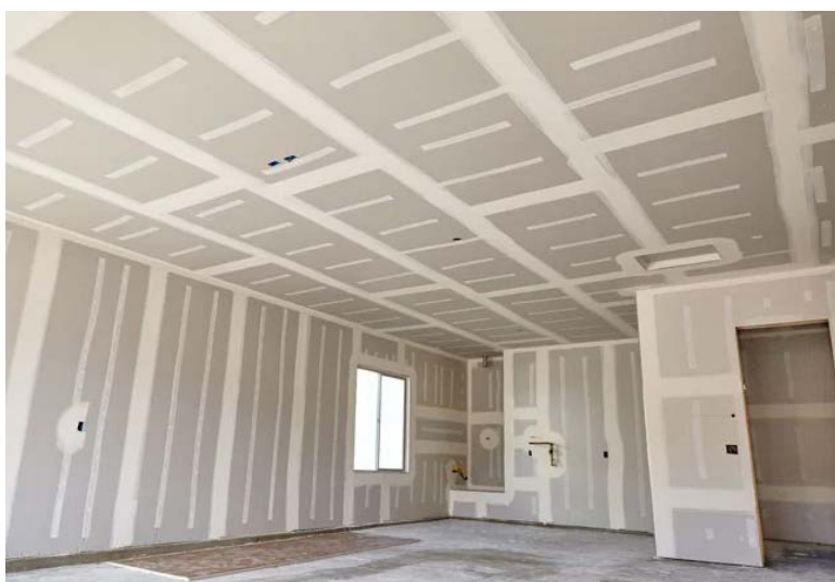
Figura 24 - Acabamento de drywall
