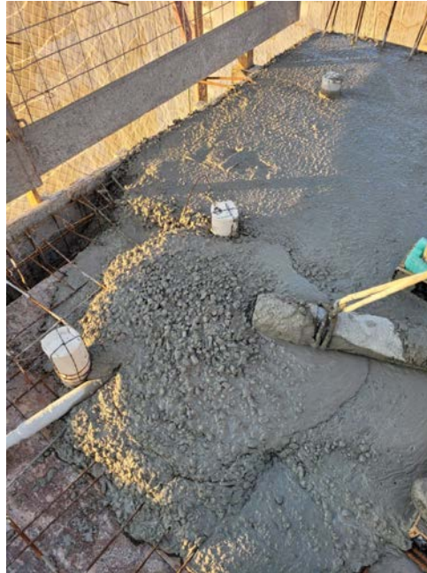
Figura 14 - Concretagem de uma laje utilizando formas metálicas;
