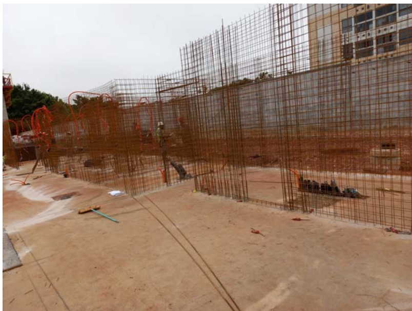
Figura 4 - Telas de aço de 6,3 mm para uma futura parede de concreto
