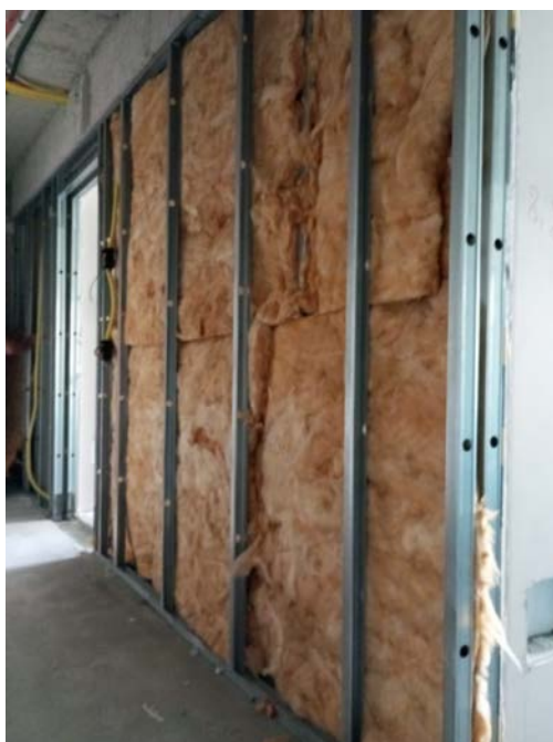
Figura 32 - Instalação da Lã de Vidro para Acústica;
