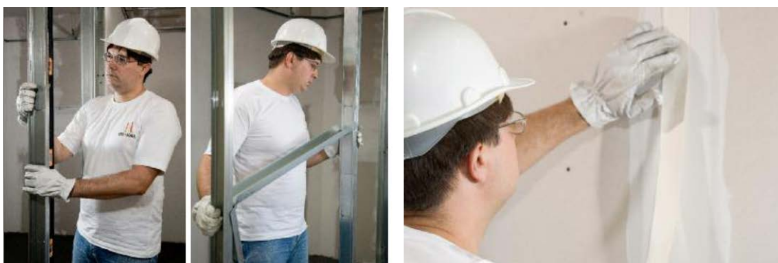
Figura 25 – Estrutura de aço galvanizado;
