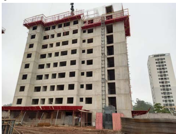
Figura 1 - Transferência de nível da forma metálica
