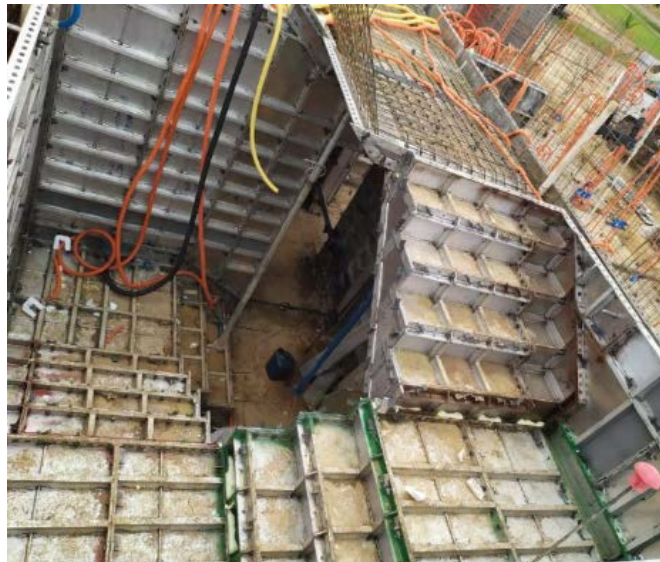
Figura 12 - Pavimento moldado com formas metálicas
