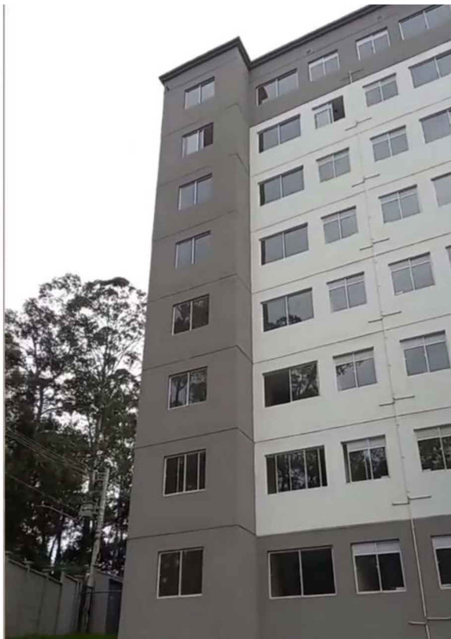
Figura 16 - Edificação para ser entregue com o método parede de concreto;
