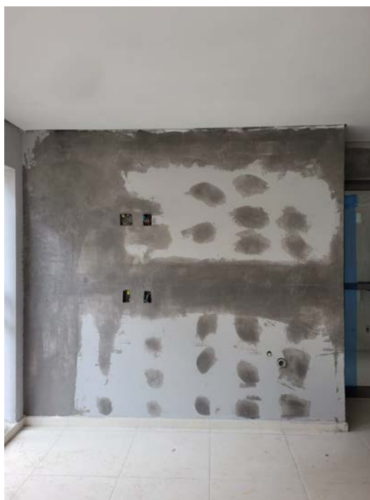
Figura 28 – Chapas de placas cimentícias acabadas;
