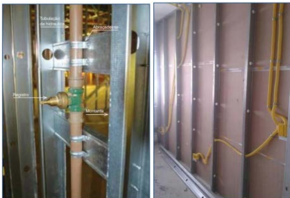
Figura 20 - Instalações de elétrica e hidráulica;
