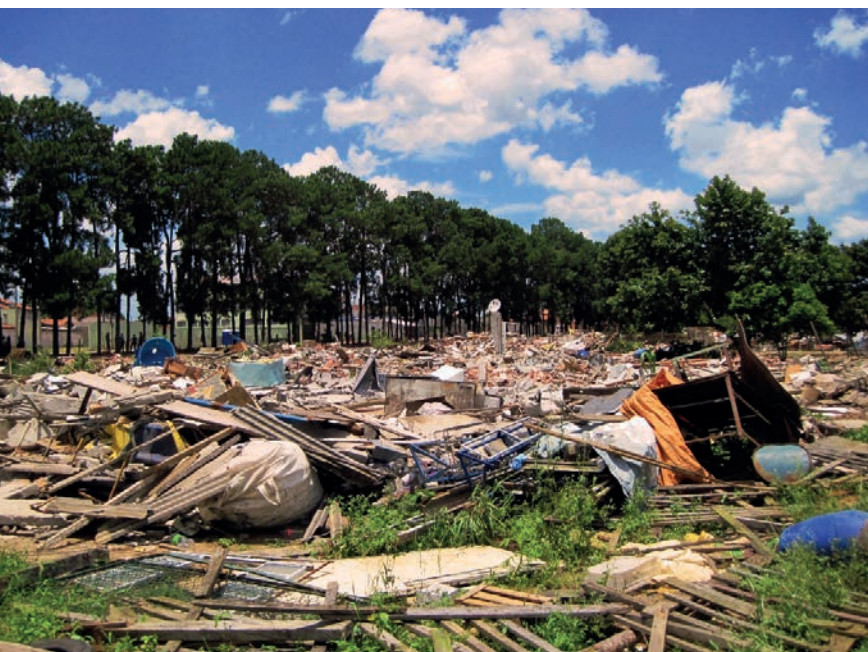
Destroços das casas demolidas depois da ação policial no Pinheirinho. Foto: Coletivo Grupo Risco/Flickr
