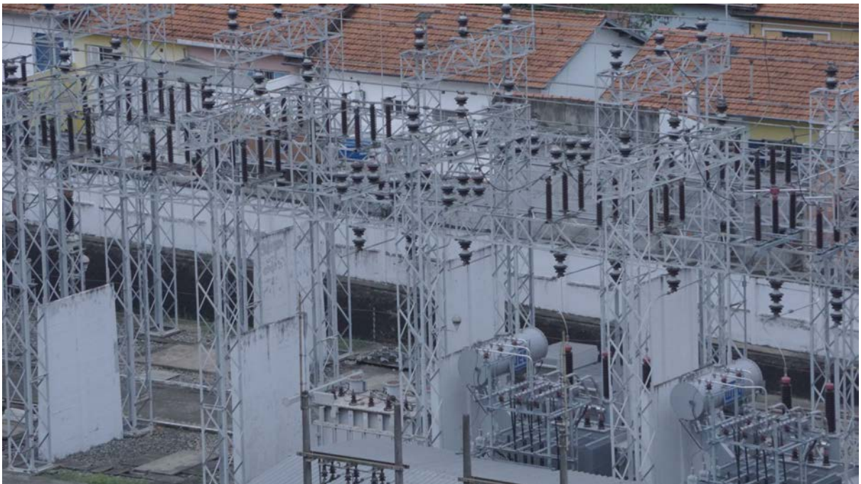
Posto de energia residencial no bairro Sumarezinho, São Paulo, 2023.
