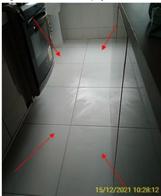
Figura 45 - Retirada das peças cerâmicas - 2
