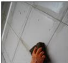
Figura 6.3-2: Acabamento e limpeza do rejunte.
