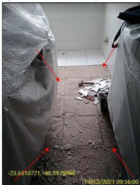
Figura 44 - Retirada das peças cerâmicas
