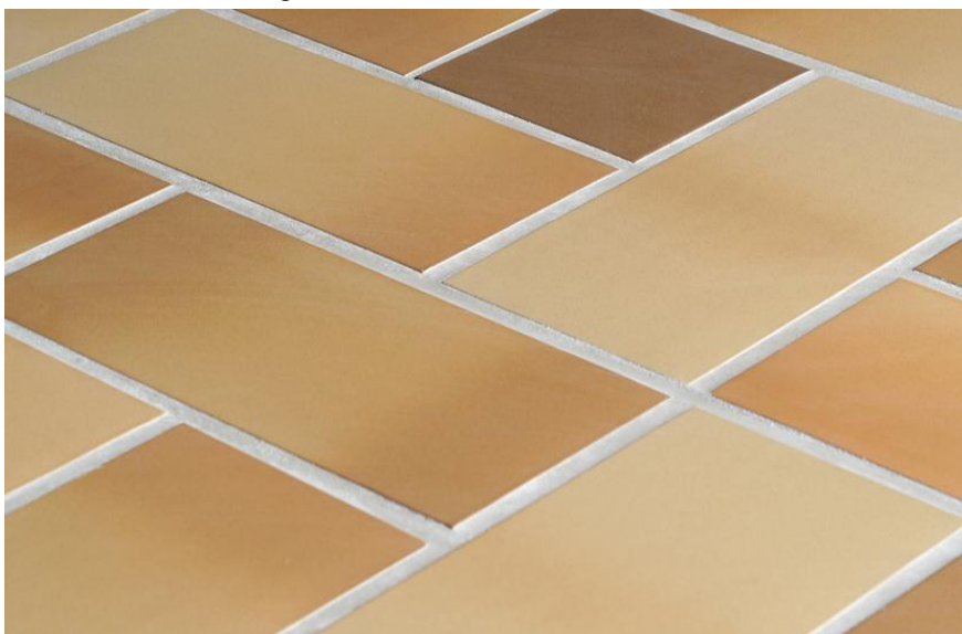
Figura 14 - Juntas de assentamento
