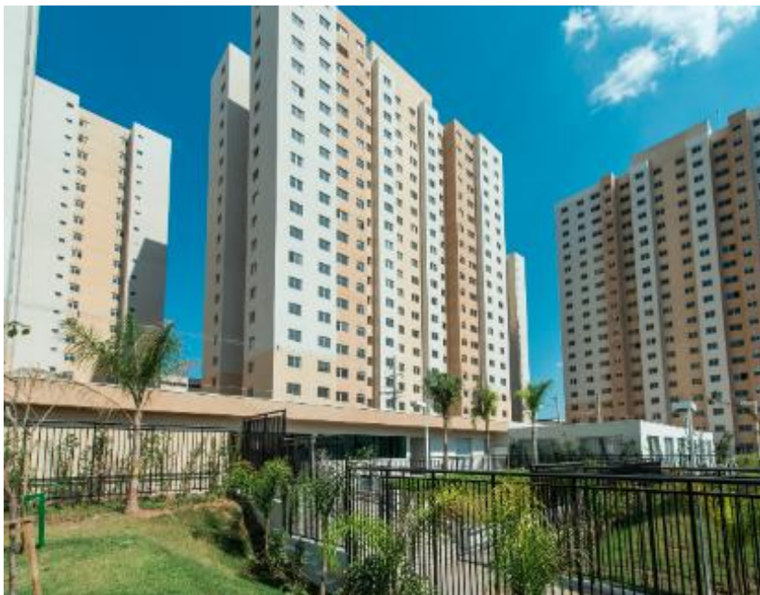
Figura 27- Fachada Condomínio Residencial
