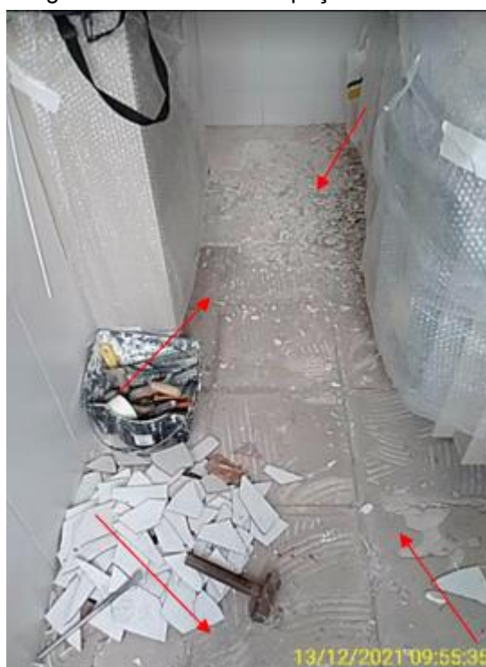
Figura 43 - Retirada das peças cerâmicas
