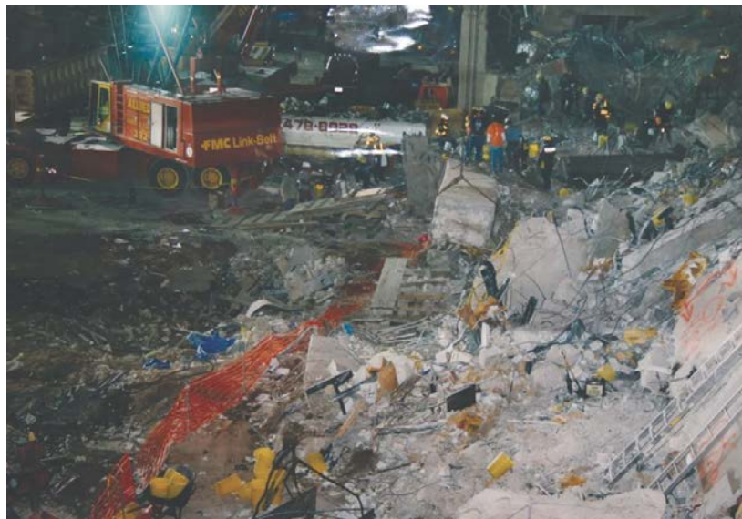
Foto dos escombros do World Trade Center após bombardeamento em 1993. Fonte: Federal Bureau Investigation (FBI). Disponível em:
