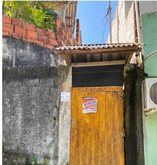
Figura 55 - Residência com a placa laranja
