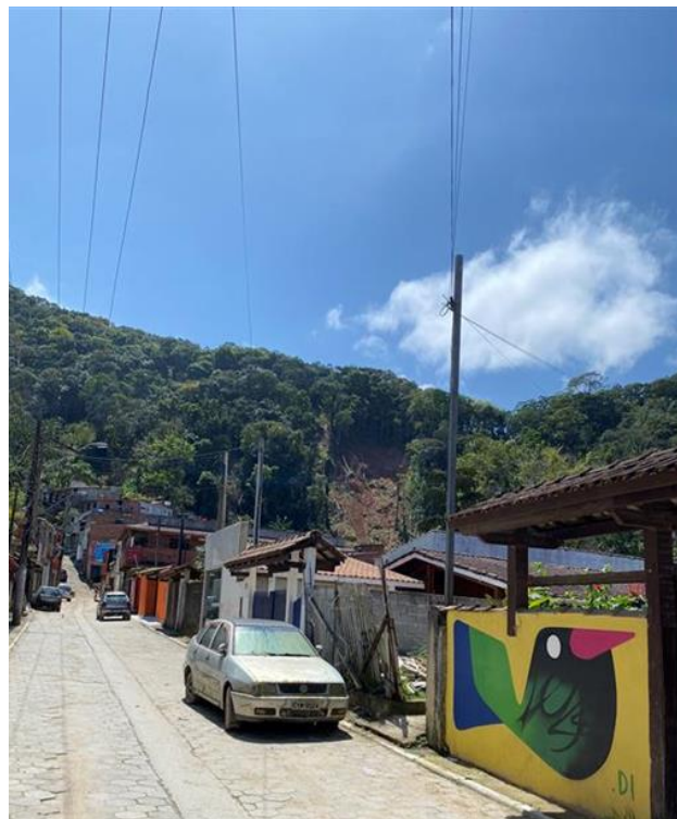
Figura 59 - Área do deslizamento vista de baixo para cima
