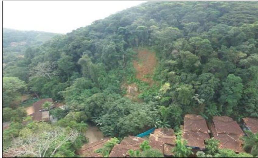
Figura 10- Escorregamento Planar Afetando Moradias no Bairro Cambury, São Sebastião, SP
