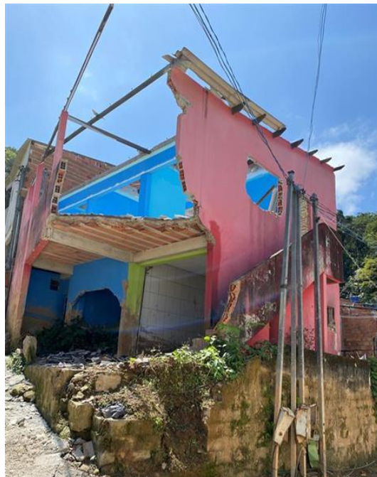
Figura 56 - Residência em processo de demolição
