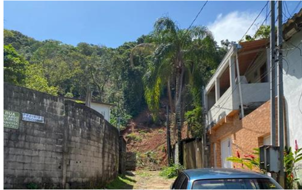
Figura 62 - Casas em bom estado
