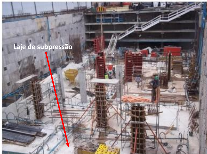
Figura 36 – Laje de subpressão concluída. Fonte: adaptado de BRITEZ et al. (2014).
