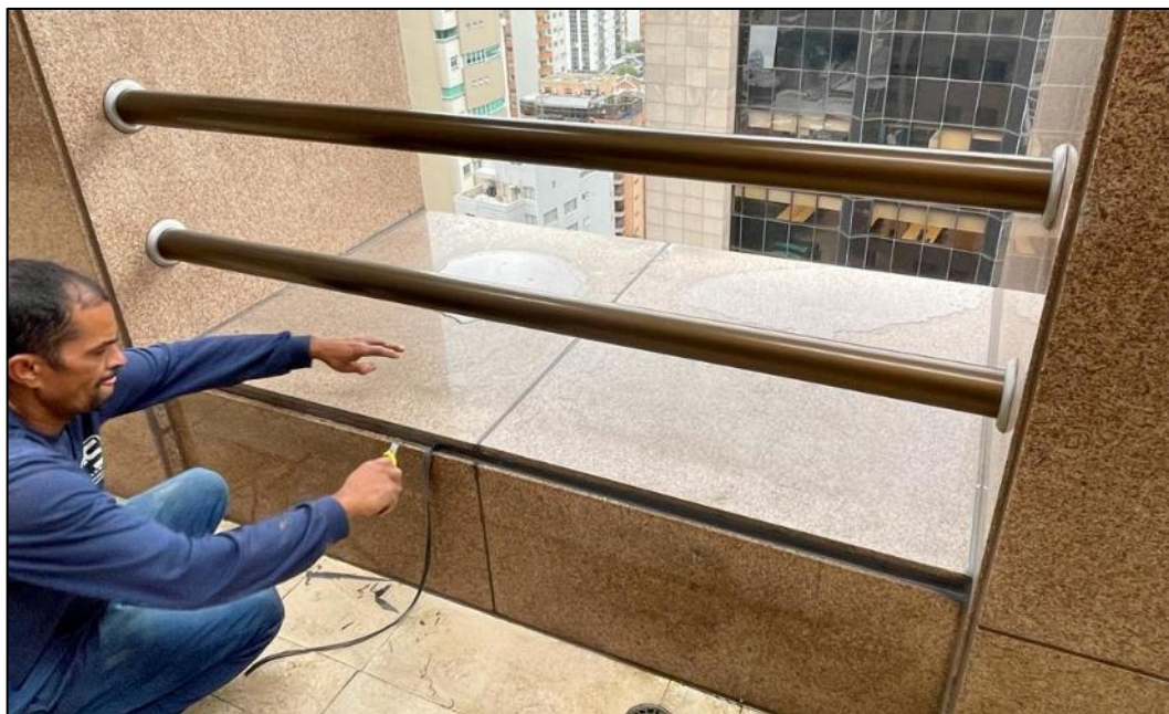
Figura 74 – Profissional removendo silicone de rejuntamento das interfaces em granito para início dos reparos.
