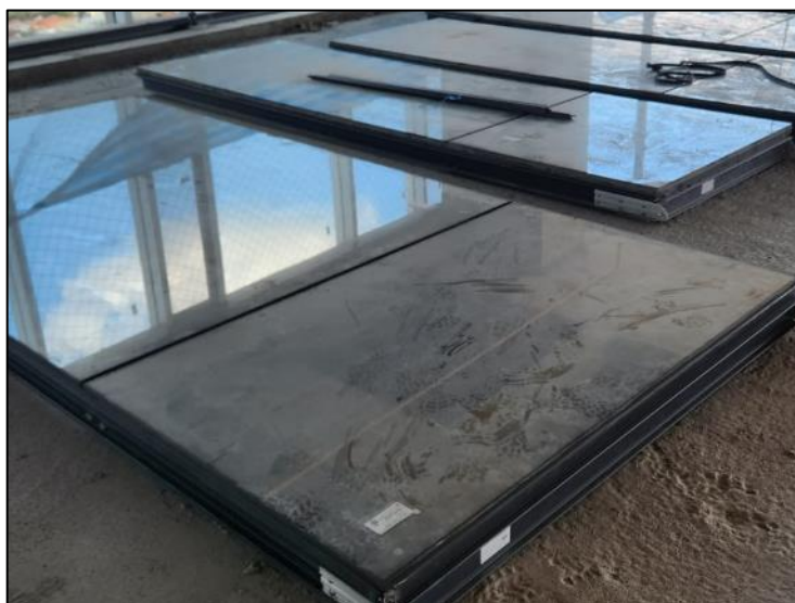
Figura 38 – Módulos unitizados para serem instalados no pavimento.
