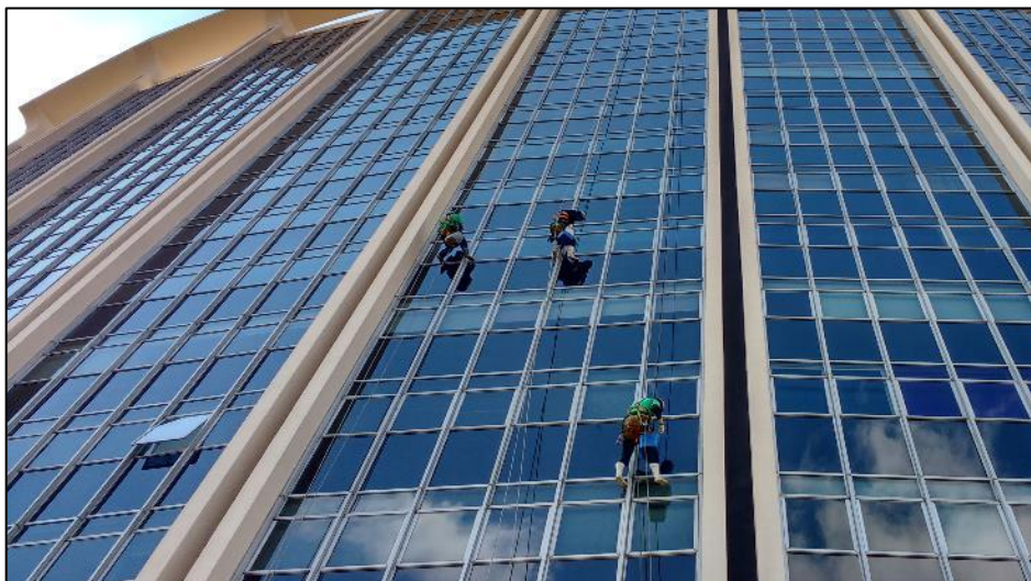
Figura 32 – Processo de vedação da fachada cortina.
