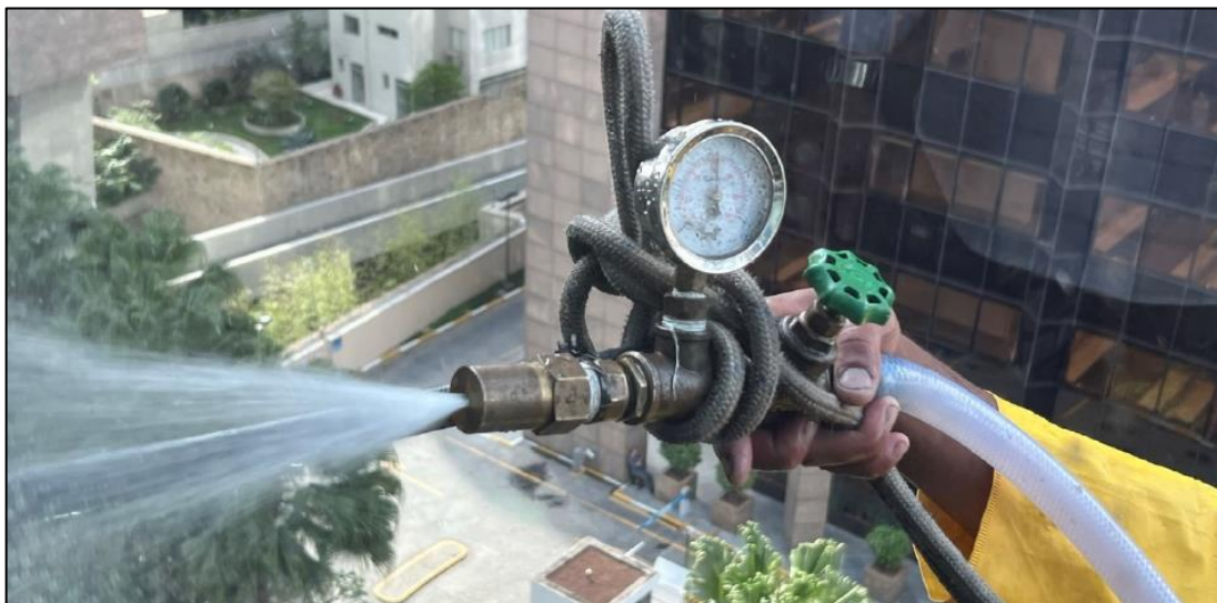
Figura 82 – Evidenciação da regulagem de pressão para realização do ensaio.
