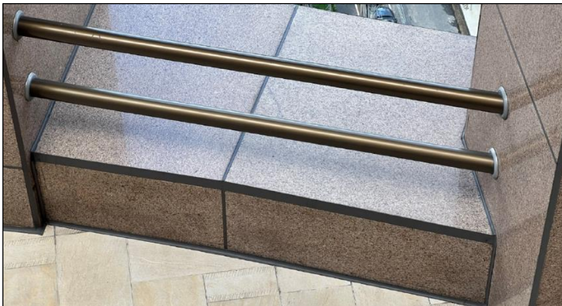
Figura 81 – Vista externa da junta horizontal de silicone no topo da fachada-cortina evidenciando o acabamento “ espatulagem ” da junta de silicone em conformidade.
