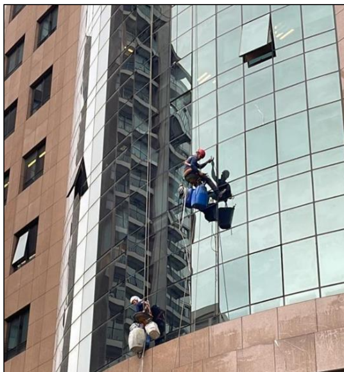
Figura 75 – Profissionais removendo as gaxetas externas da fachada-cortina para início dos reparos
