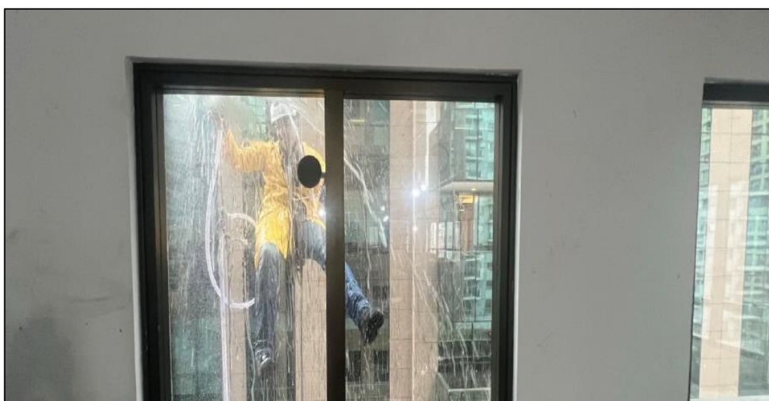
Figura 86 – Ambiente interno evidenciado sem nenhum ponto de infiltração durante a realização do ensaio.
