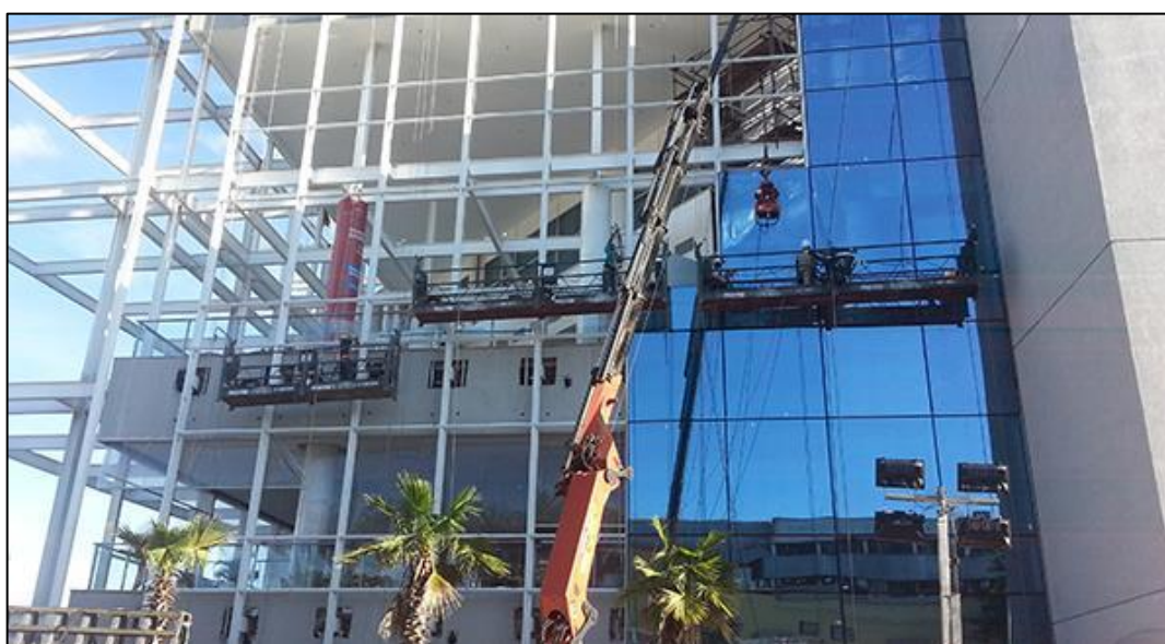
Figura 34 – Instalação de fachada stick com equipamentos de apoio.
