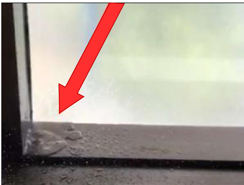
Figura 47 – Módulo de fachada desalinhado.
