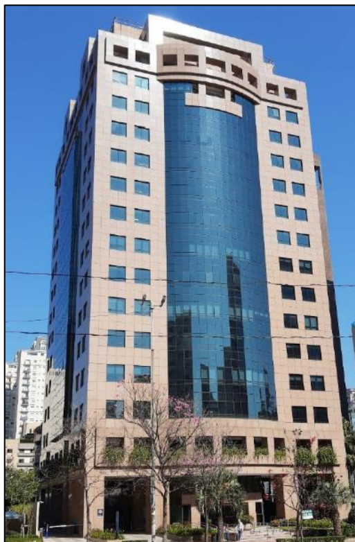
Figura 59 – Edifício Seculum I .
