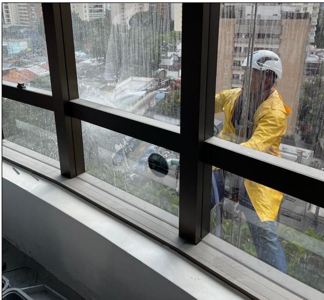
Figura 84 – Profissional posicionado na face externa realizado o ensaio na fachada-cortina (II).
