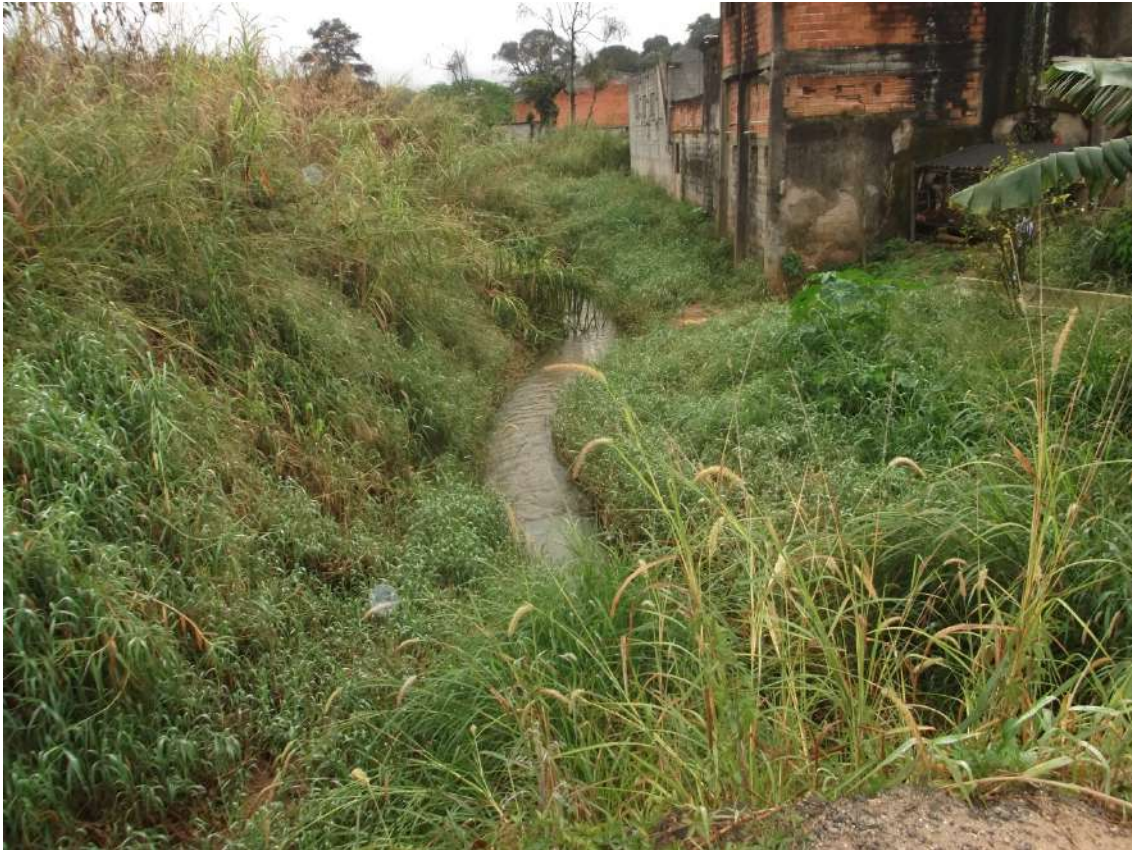
Imagem 10: Habitação próxima as águas do córrego (silva 2013).
