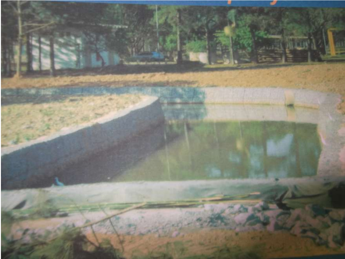
Imagem 20: Estação de tratamento da Sabesp (silva 2013)
