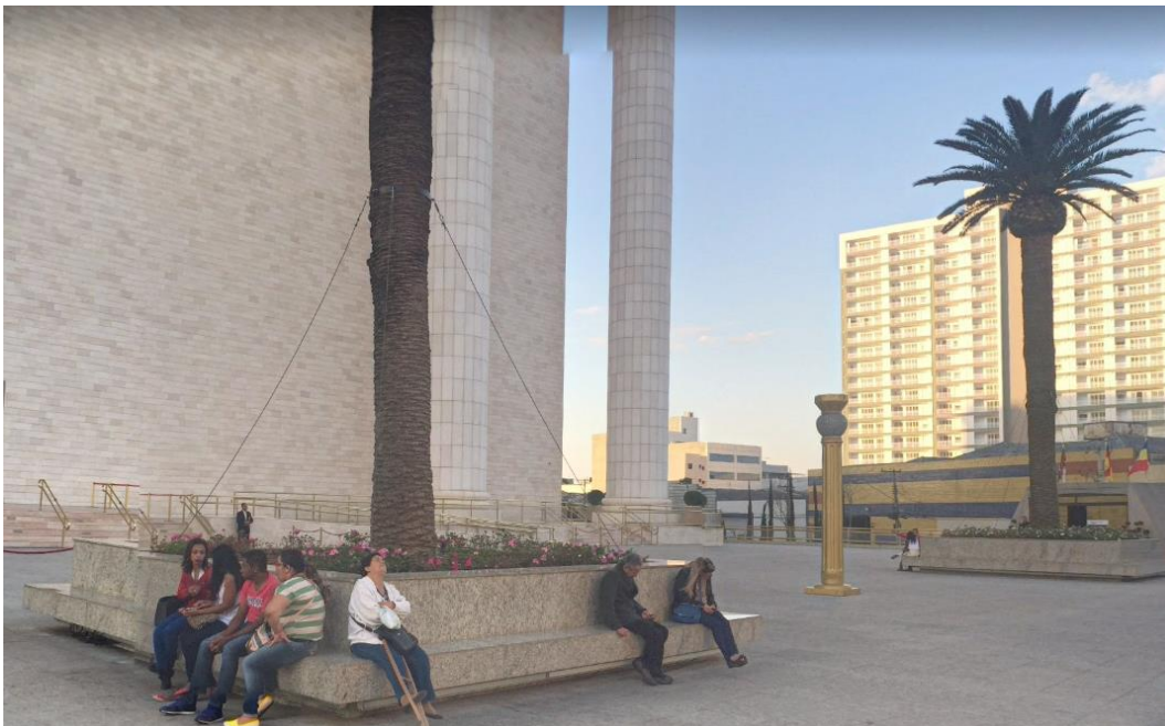
Figura 71 – Templo de Salomão da IURD: estruturas revestidas de granito que servem de vasos para as tamareiras e de banco para os visitantes.
