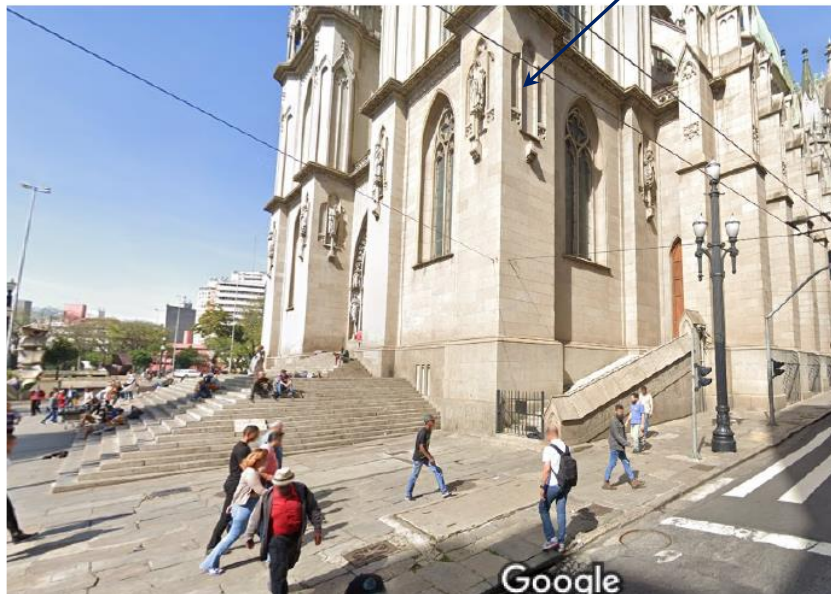
Figura 21 - Vista dos nichos da parede da lateral direita da torre de 92 metros.
