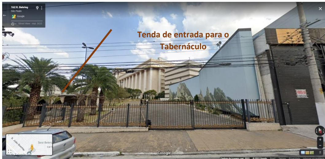
Figura 66 – Templo de Salomão da IURD – Fachada dos fundos pela rua Behring.
