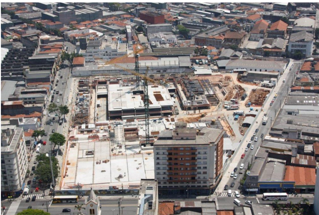
Figura 73 – Vista aérea de 05/11/11 da fase construtiva do Templo de Salomão da IURD.
