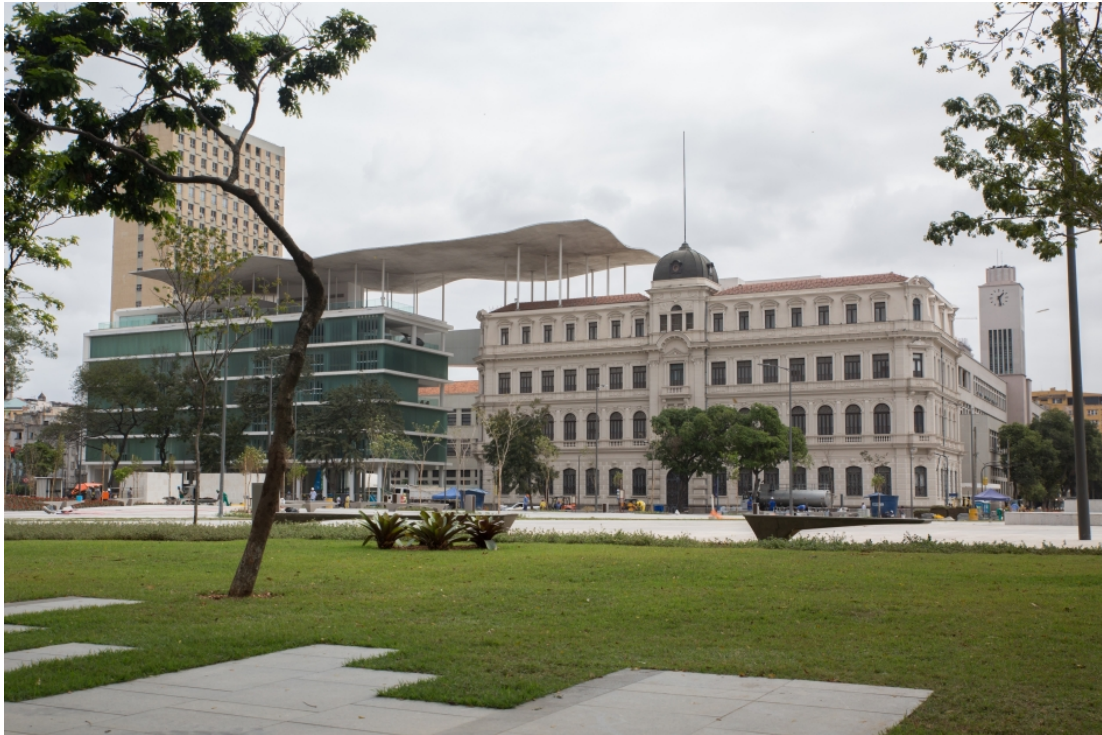
Vista do complexo de prédios do Museu de Arte do Rio (Crédito: Thales Leite / Museu de Arte do Rio).
