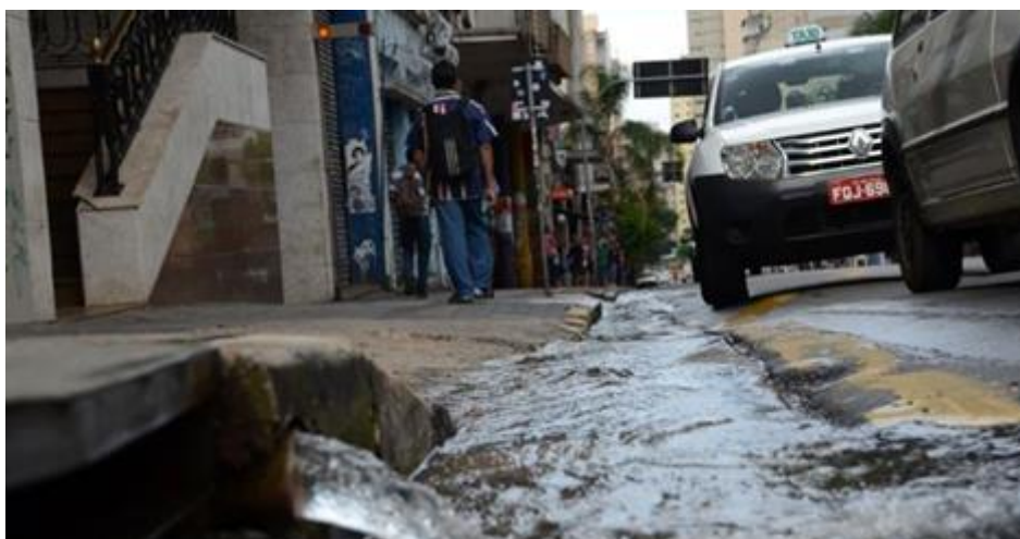
Edifício Capital Augusta. Edifício joga fora, na Rua Augusta, água drenada de subsolo.
