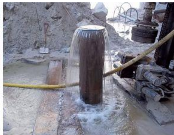
Figura 4. Refluxo de água do terreno durante execução das estacas e sistema para rebaixamento do nível d'água
