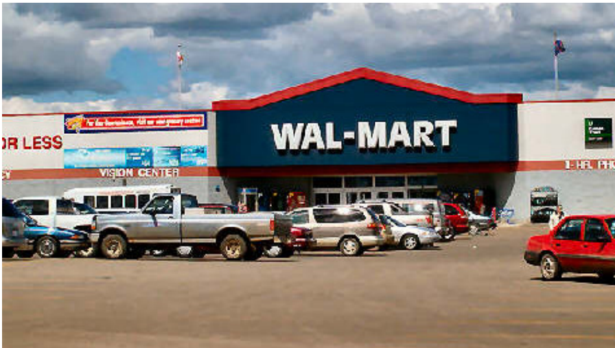
Figura 9: Fachada Walmart USA
