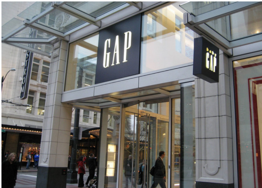
Figura 2: Fachada Loja GAP U.S.A
