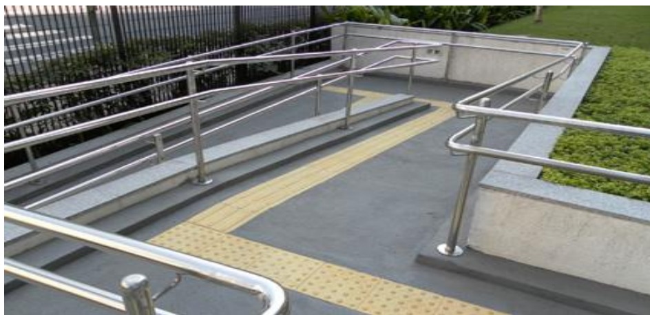
Figura 5 - Rampas garantem a acessibilidade
