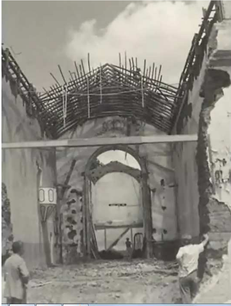
Figura 7: Vista da nave central durante a demolição. (Fonte: Arquivo Municipal de Mogi das Cruzes)
