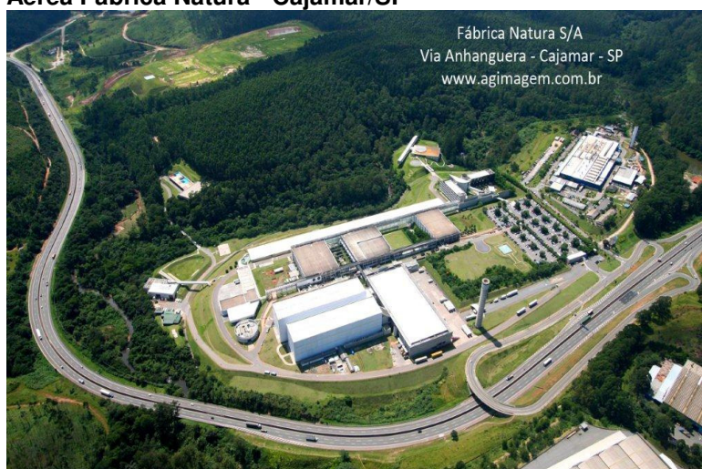
Figura 8 - Vista Aérea Fábrica Natura - Cajamar/SP
