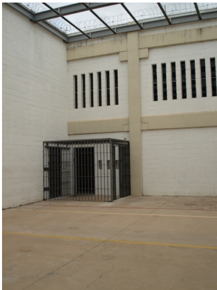
pátio para banho de sol com teto fechado
