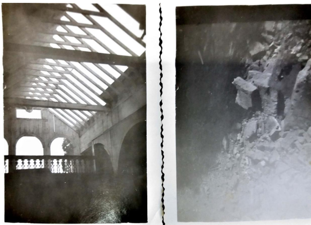
Fotografia 11: Demolição da Igreja de Nossa Senhora do Rosário. Vista interna (1952).
