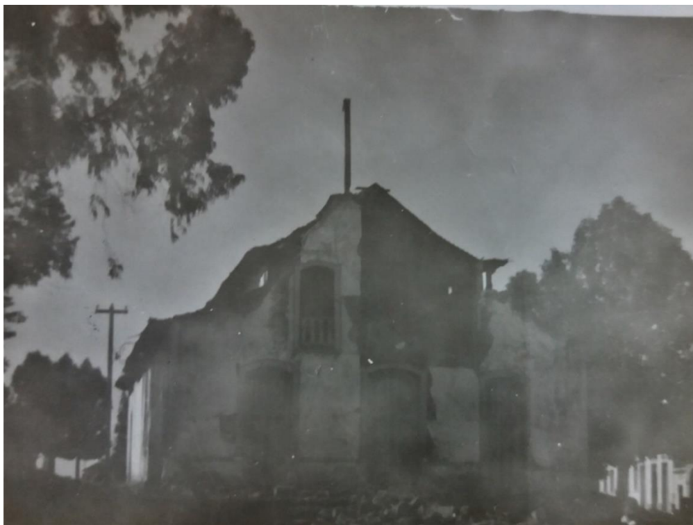
Fotografia 10: Demolição da Igreja de Nossa Senhora do Rosário. Vista externa (1952).
