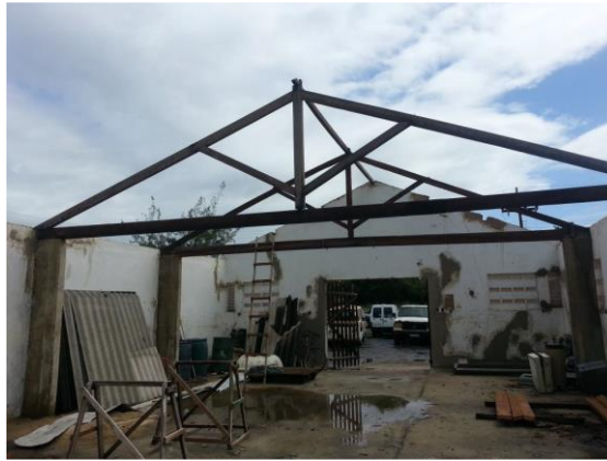
Figura 3 - Reforma de galpão para uso como centro náutico em Tamandaré (PE).
