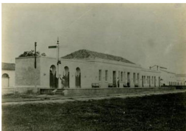
Figura 8 - 1ª estação da Luz, inaugurada em 1867. Fonte: Arquivo R.F.F.S.A.
