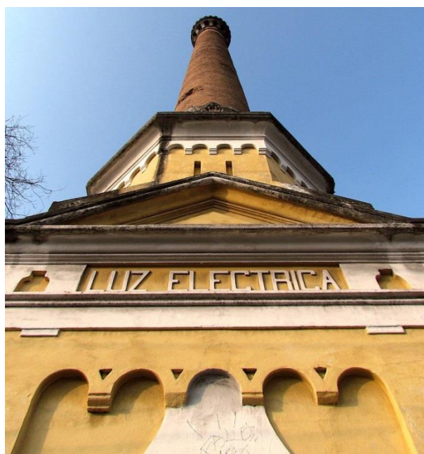
Figura 16 - Chaminé da usina da Luz, reforma executada pelo programam Monumenta. Foto: Fernando Rebelo
