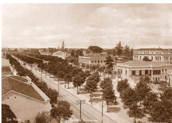
Figura 9 - Torre da Estação da Luz ao fundo, ao centro antiga Escola Politécnica, atual Centro Paula Souza, 1920.
