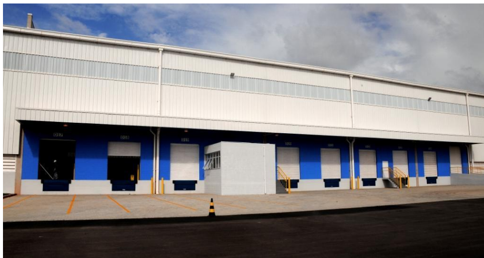
Figura 5: Centro de Distribuição Decathlon em Embu (SP)
