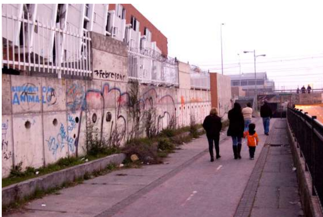
Figura 11. Habitantes da cidade caminham ao lado do edifício danificado no terremoto de 27 de Fevereiro de 2010, Concepción, Chile. (Mihara, 2011)
