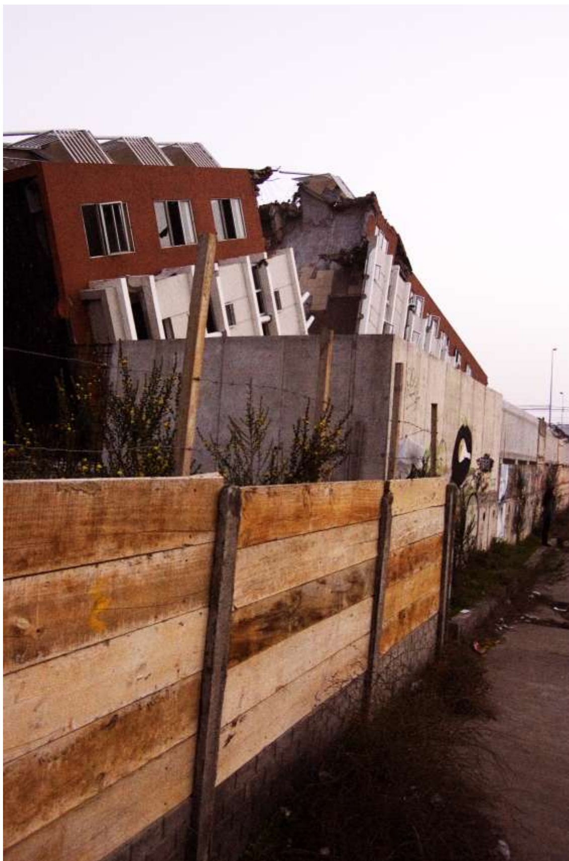
Figura 2. Edifício danificado no terremoto de 27 de Fevereiro de 2010, Concepción, Chile. (Mihara, 2011)
