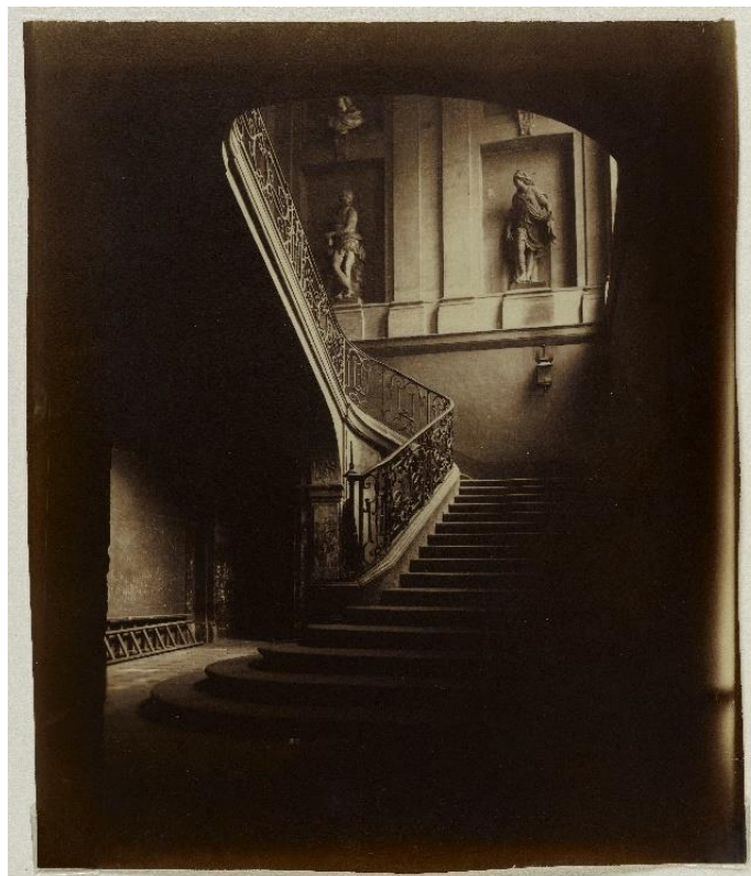
Fotografia 20. Eugène Atget. Escalier de l'Hôtel de Tallard, 78, rue des Archives, 1901-02. Impressão abulminada, 21,3x17,9. Musée Carnavalet, Histoire de Paris.
