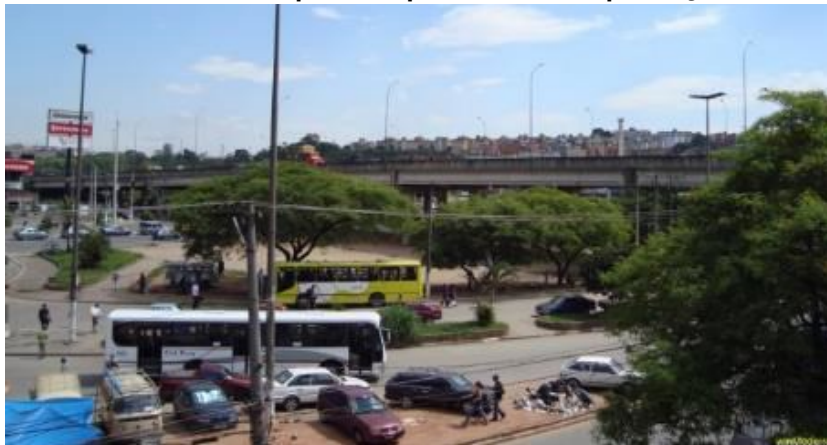
Foto 6. - Vista do local previsto para a futura implantação do Terminal Km 21.
