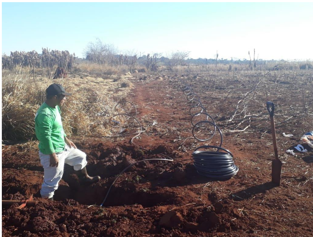
Figura 17 - Instalação de rede distribuição na TI Guyra Roka
