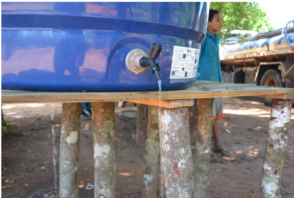
Figura 21 - Caixas d'água utilizadas como cisternas na Aldeia Laranjal
