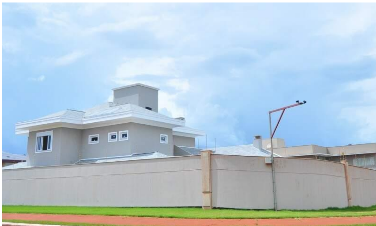
Figura 2 - Muros dos condomínios vizinhos as Reserva Indígena de Dourados (MS)
