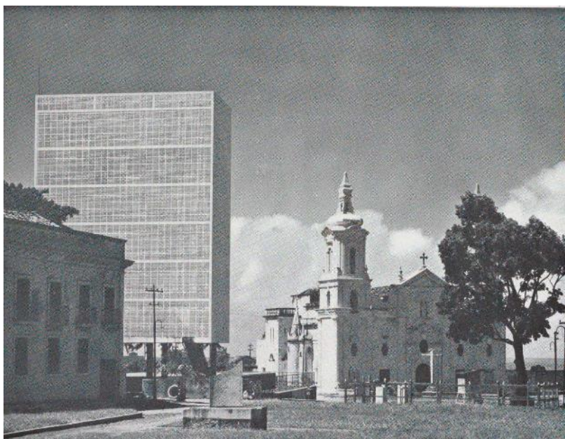
Figura 24 - Torre d'água em Olinda, Pernambuco. Fonte: Brazil Builds, p.158. 148
