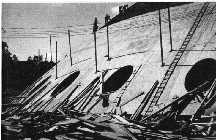
Figura 178 – Palácio das Artes em construção. Fonte: Módulo n. 1, março de 1955.
