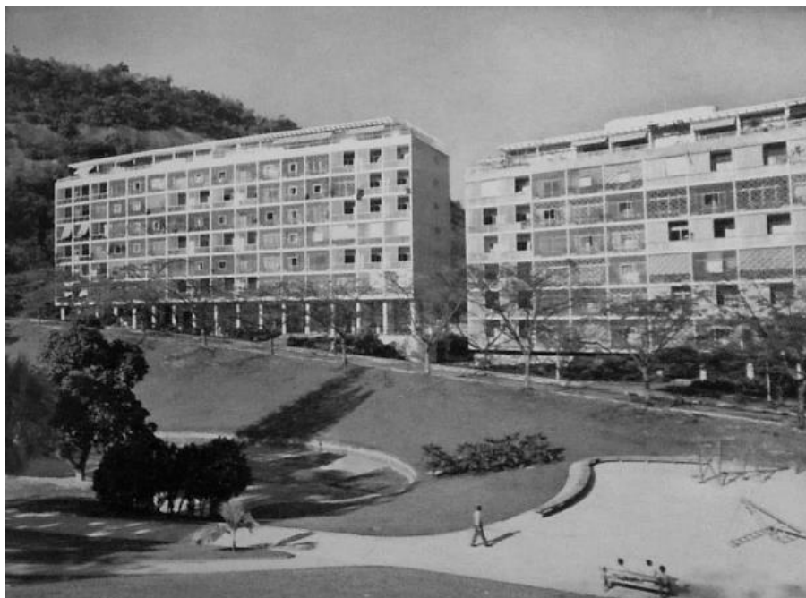
Figura 101 - As torres isoladas do Parque Guinle, com o morro emoldurando a torre à esquerda e o agenciamento da área livre à frente. Fonte: Latin American Architecture Since 1945 , p.155.
