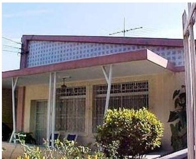
Figura 1 - Popularização da arquitetura moderna. Bairro Barreiro, Belo Horizonte. Fonte: “A insustentável leveza da modernidade”, Fernando Luiz Lara 34
