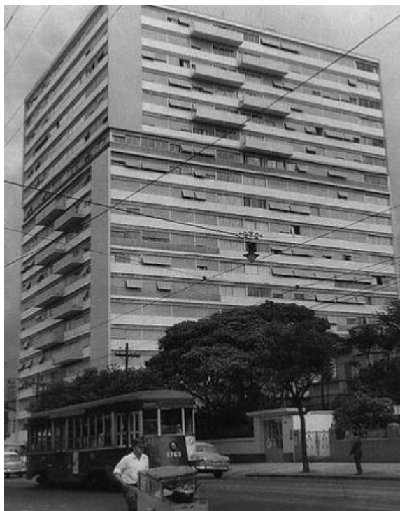
Figura 156 – Edifício Três Marias. Fonte: Revista Habitat, nº 7, 1952, p.18
