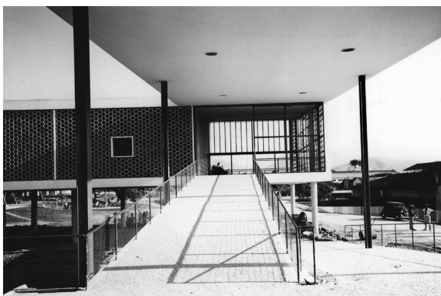
Figura 103 - Escola Primária do Conjunto Residencial Prefeito Mendes de Moraes — Pedregulho, 1947-1950. Rampa de entrada. Foto de Marcel Gautherot. Fonte: Centro de Documentação – MAM.
