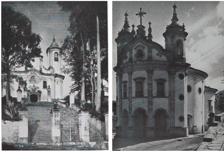
Figuras 21 e 22 - Nossa Senhora do Carmo (1766) & Nossa Senhora do Rosario dos Pretos (1785), Ouro Preto - Minas Gerais. Arquitetos Manuel Francisco Lisboa & Jose Pereira Arouca. Fonte: Brazil Builds, p.50 & p.55, respectivamente.
