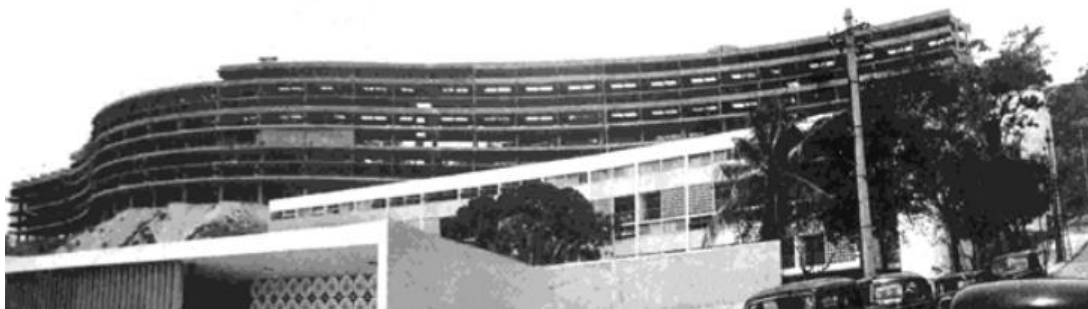
Figura 110 - Centro de saúde no primeiro plano, o bloco B no segundo plano, e ao fundo o bloco A em obras do Conjunto Residencial Pedregulho. Fonte: L'Architecture d'Aujourd'hui, 1952, n.42-43
