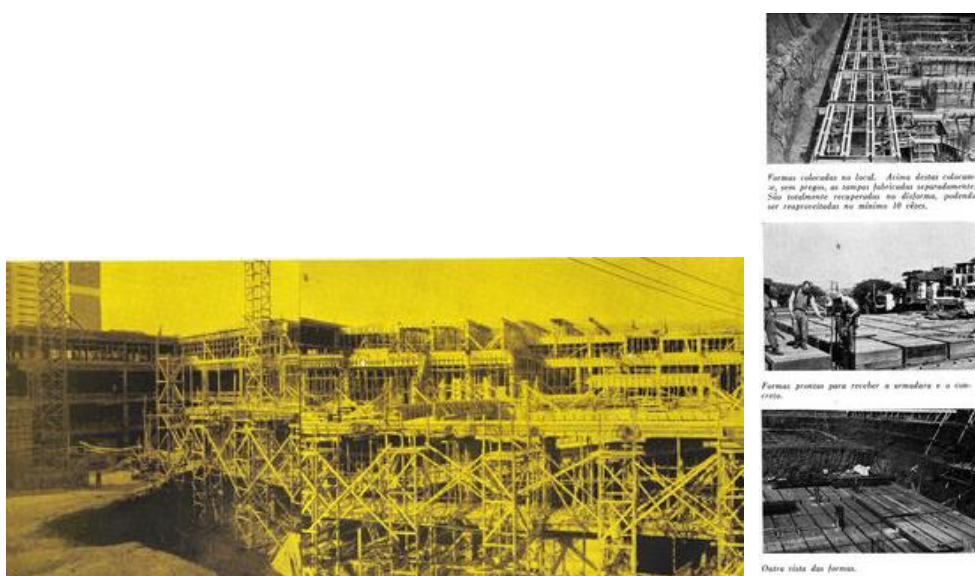
Figura 169 – Conjunto Nacional em construção. Fonte: Acrópole, Apr 1957 - Nº 222, p.208 & 211
