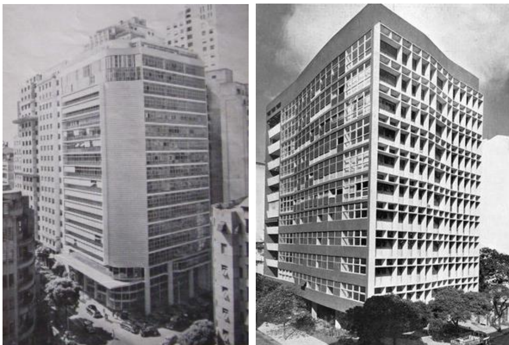
Figuras 87 e 88 –. Edifício Seguradoras no Rio de Janeiro & Edifício de apartamentos em Copacabana. Fontes: Fonte: BAC nº1. 1953, p.23, Acrópole Nov 1955 - Ano 18 - Nº 206, p.52, respectivamente
