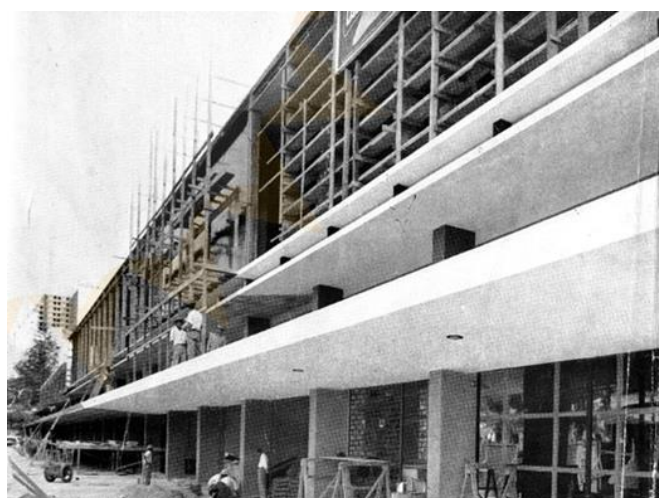
Figura 163 – Conjunto Nacional em construção. Fonte: Acrópole N.222, 1957, p.209.
