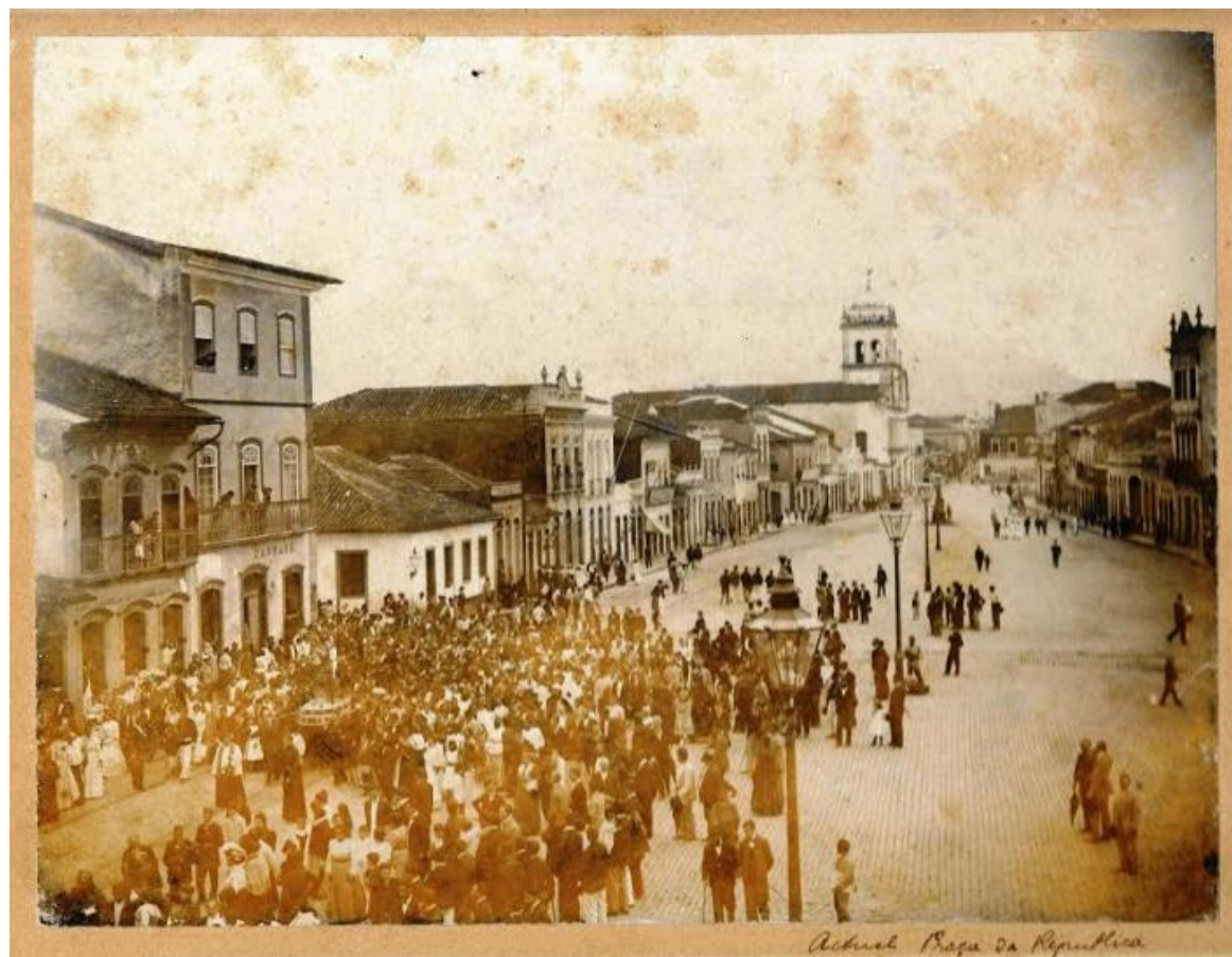
Figura 11 – Antigo quartirão das “casinhas” visto do Largo da Matriz depois da desapropriação, transformado após 1889 em Praça da República. 250
