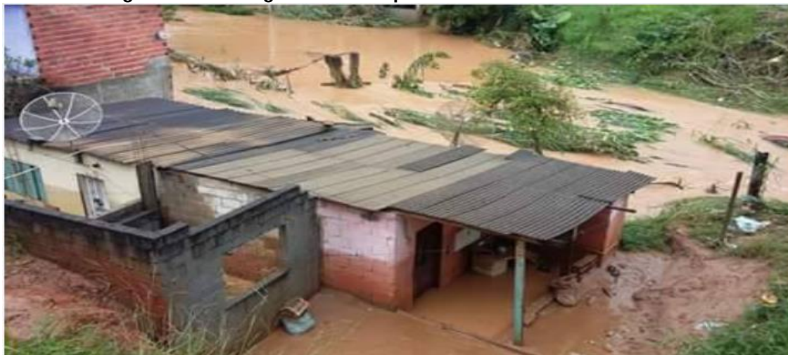
Fotografia 11 - Estragos causados pelas fortes chuvas no Jardim Silvia
