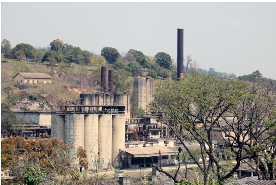
Figura 14. Imagem do patrimônio da fábrica Cimento Perus, atualmente abandonado e sob as mãos do capital especulativo. Fonte: Ira Romão/Agência Mural (2018)
