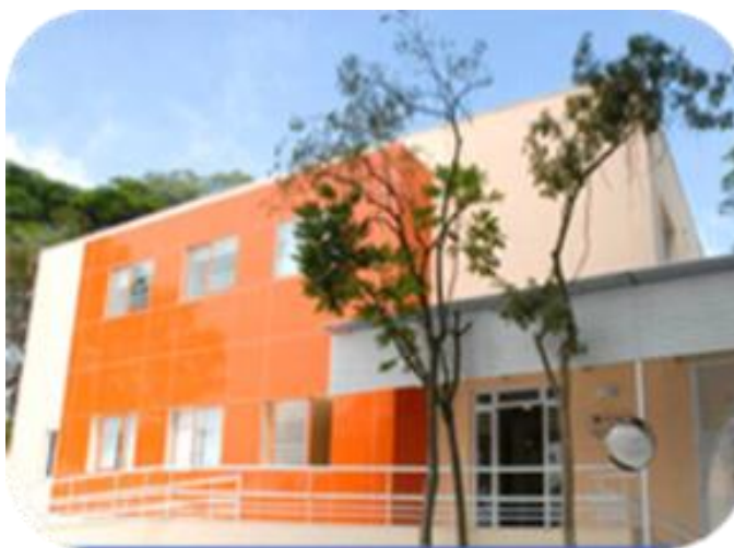
Figura 34 - Creche Estrela de Davi – Estrutura Nova
