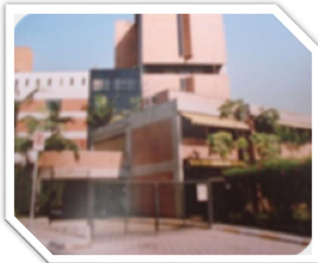
Figura 33 - Creche Estrela de Davi – Estrutura Antiga
