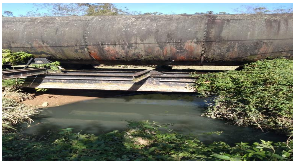
Foto: 03 Adutora do sistema Rio Claro que abastece Ribeirão Pires e Mauá. Fonte: SVMA
