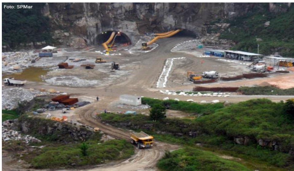
Imagem 16 - Construção do Túnel do Rodoanel sentido Mauá-Ribeirão Pires, o Rio Guaió foi aterrado e depois do término da obra foi aberta uma passagem por baixo da via, no canto esquerdo da foto entre os caminhões branco e amarelo embaixo a continuidade do leito diminuído do Rio Guaió. Fonte: SPMAR (2011)
