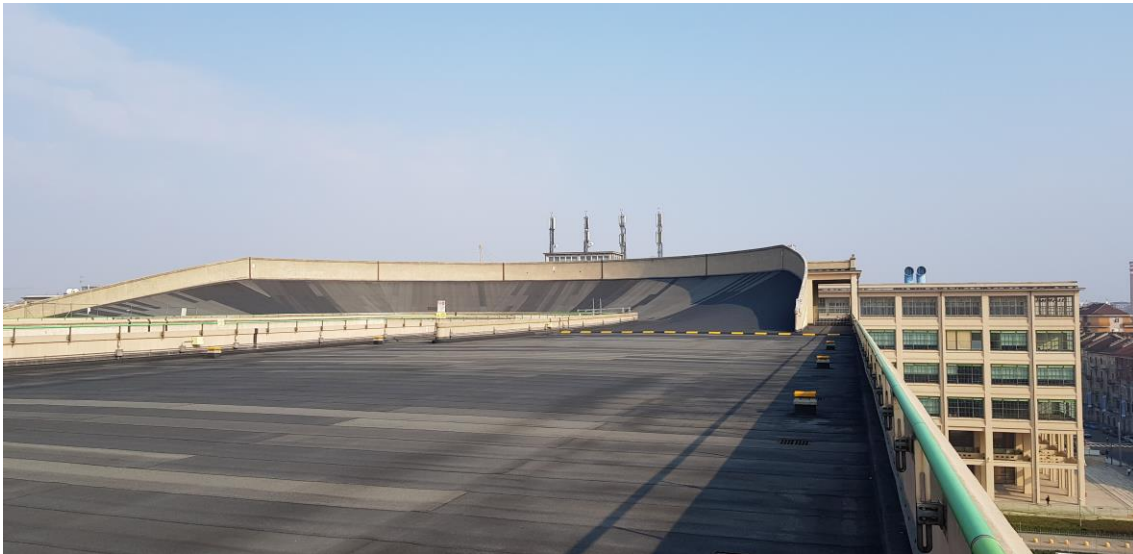
Figura 4 - Pista de testes de veículos no teto da fábrica de Lingotto (Turim).
