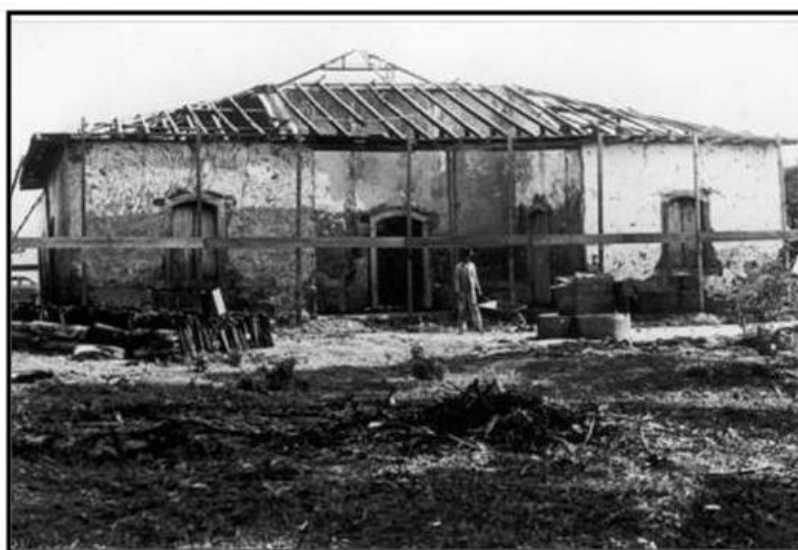
Imagem 12 - Obras de restauração. Vista da fachada principal, com destaque para a reconstrução do telhado (PMSP/SMC/DPH/DIM) (Acervo da Seção Arquivo de Negativos)
