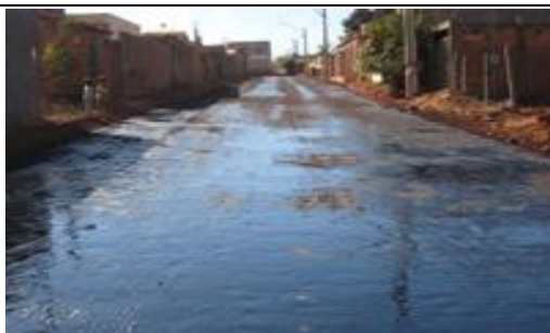
Figura 11: Aspecto das ruas de Itapoá
